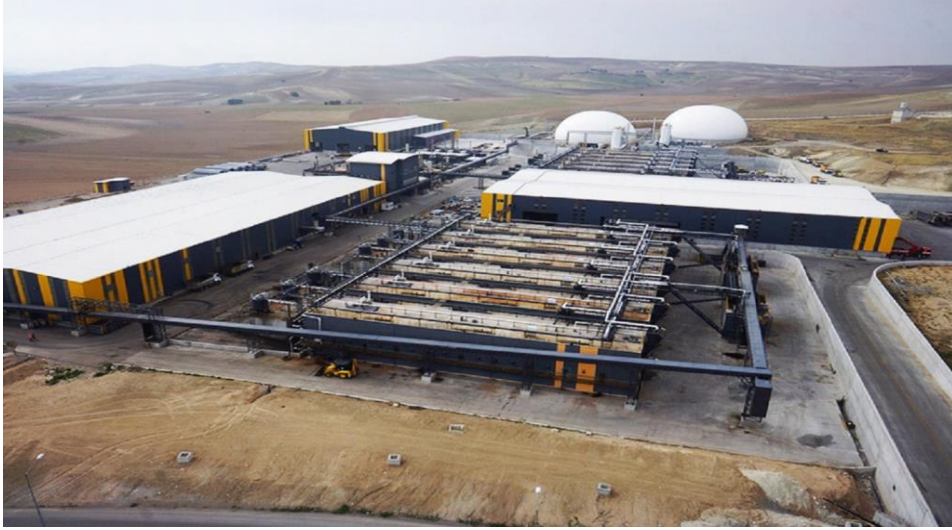
Fotoğraf 6: Ankara Büyükşehir Belediyesi Sincan-Çadırtepe katı atık tesisi 143
