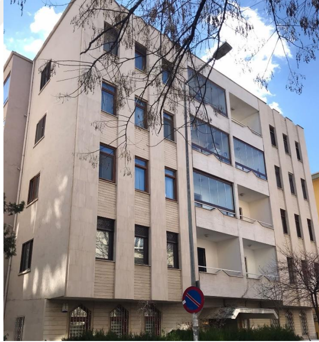
Fotoğraf 1. Güvenevler Mahallesi Bina Örneği 1
