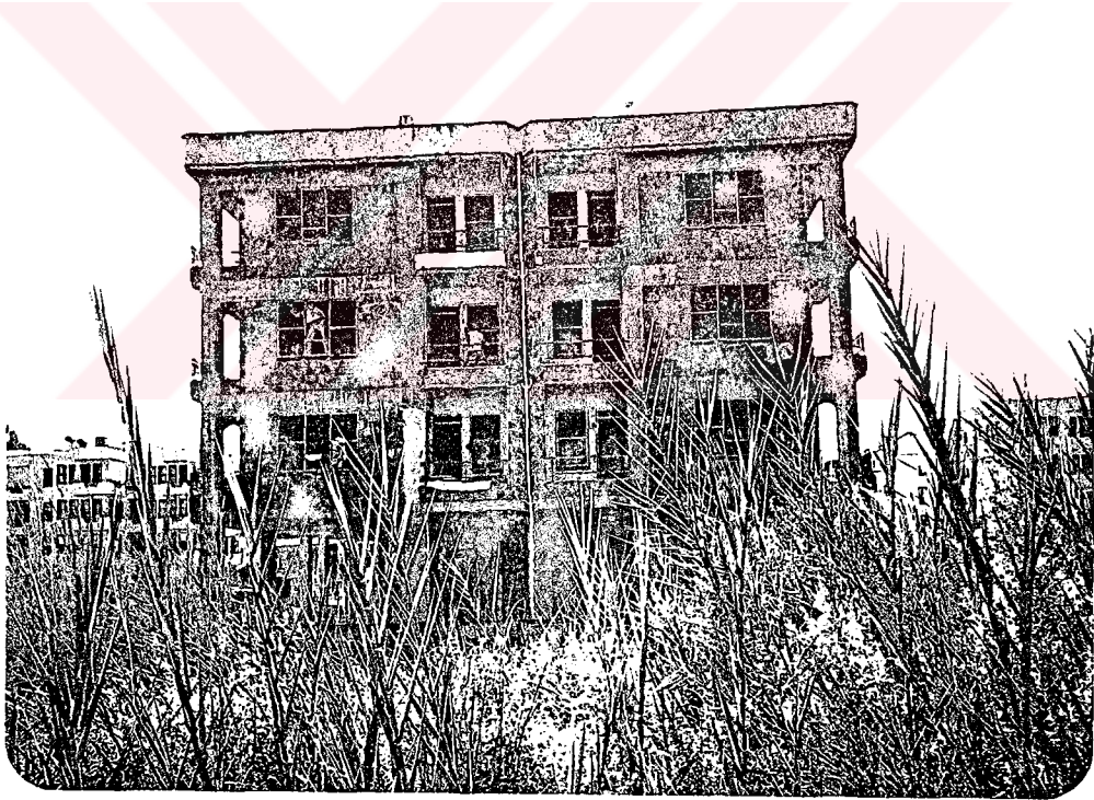
FOTO. 27 ve 28: Kentte yer yer bataklık alanları bulunmaktadır. Bu bataklıklar inşaat yapılacağı zaman sadece suyu boşaltılarak hafriyata başlanmaktadır. Bataklıklar üzerine yapılan çok katlı inşaatlar bittiğinde ise bu defa zemini su basması ve deformasyon gibi önemli sorunlarla karşılaşmaktadır. Fotoğraflarda Saray Mahallesi- deki bu tür yapılaşma görülmektedir.
