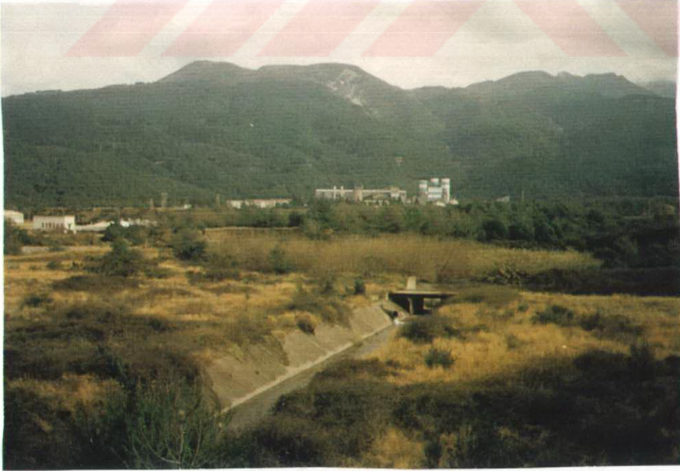
Foto 20: İskenderun Çimento Fabrikası.
