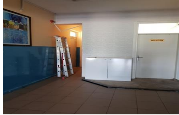
Şekil 8. Acil çıkış kapısı önünün kapanması
