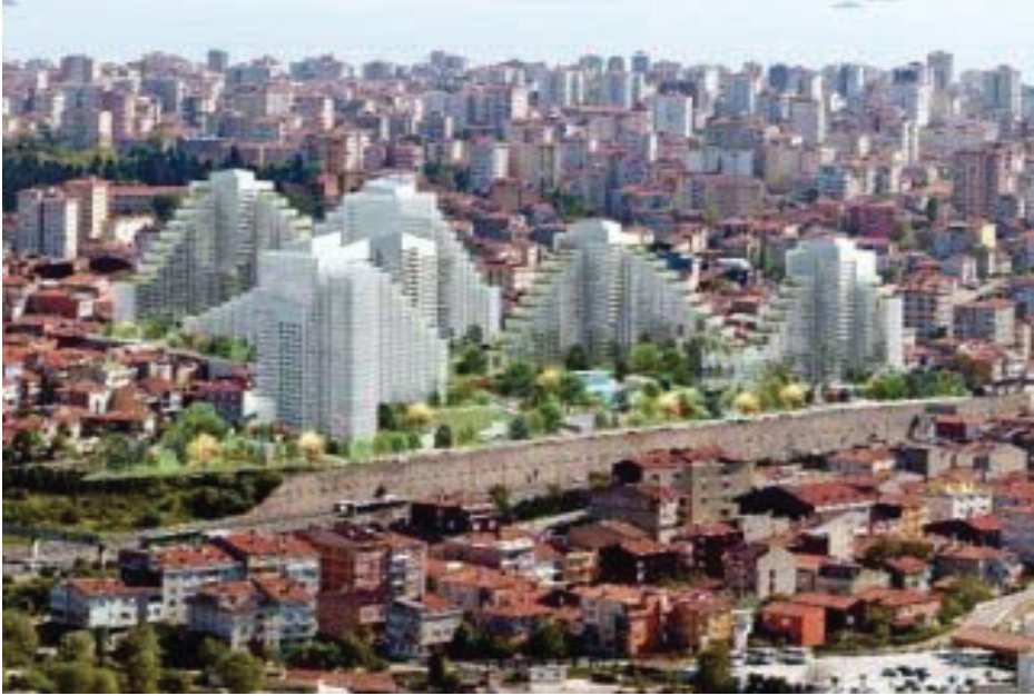
Şekil 4.20. Rezidans ve gecekonduları ayıran duvar- Fikirtepe
