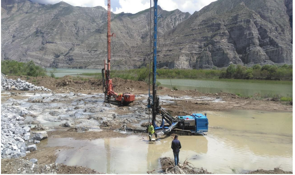
Şekil 3.4 Jet grout sistemine ait delgi makinesi
