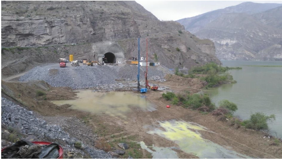
Şekil 3.33 Pirinkayalar geçidinde devam etmekte olan tünel ve stabilizasyon çalışmaları
