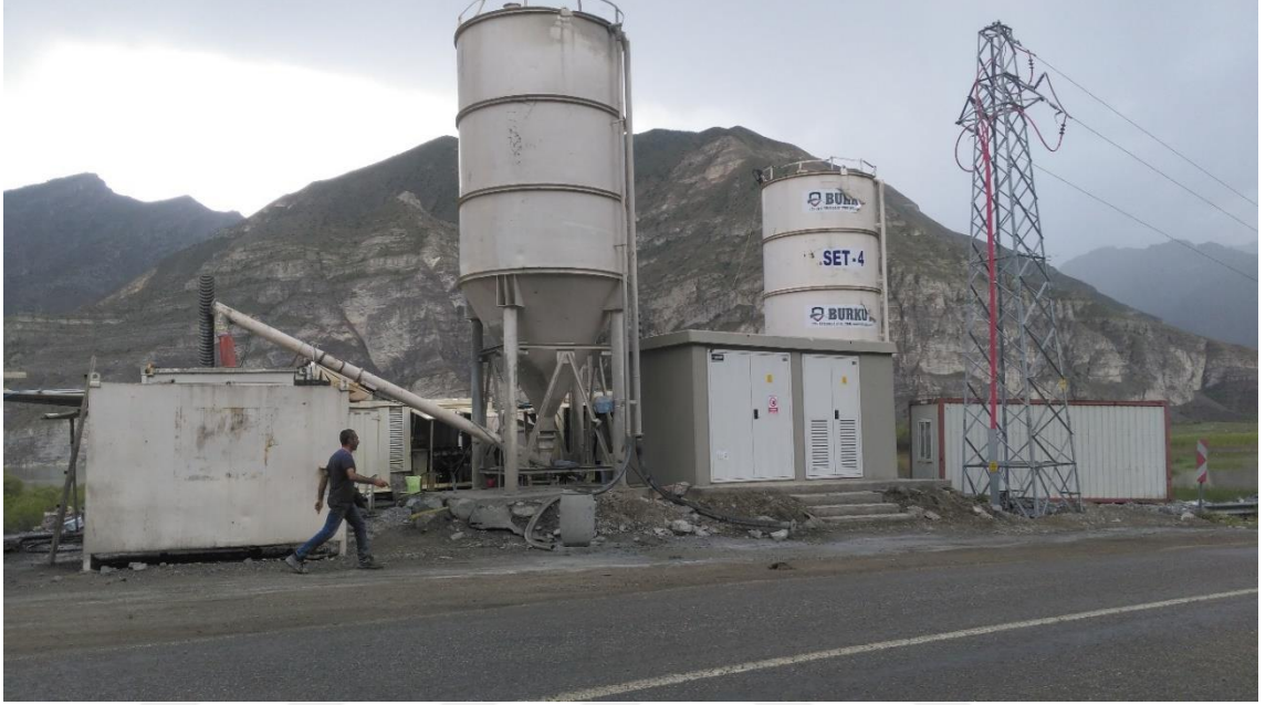
Şekil 3.7 Jet grout sisteminin genel görünüşü ve çimento silosu
