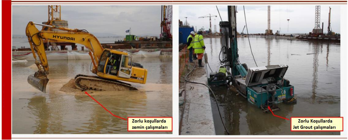
Şekil 2.8 Zorlu koşullarda gerçekleştirilen jet grout uygulaması (Pinto vd. 2016'dan değiştirilerek alınmıştır).
