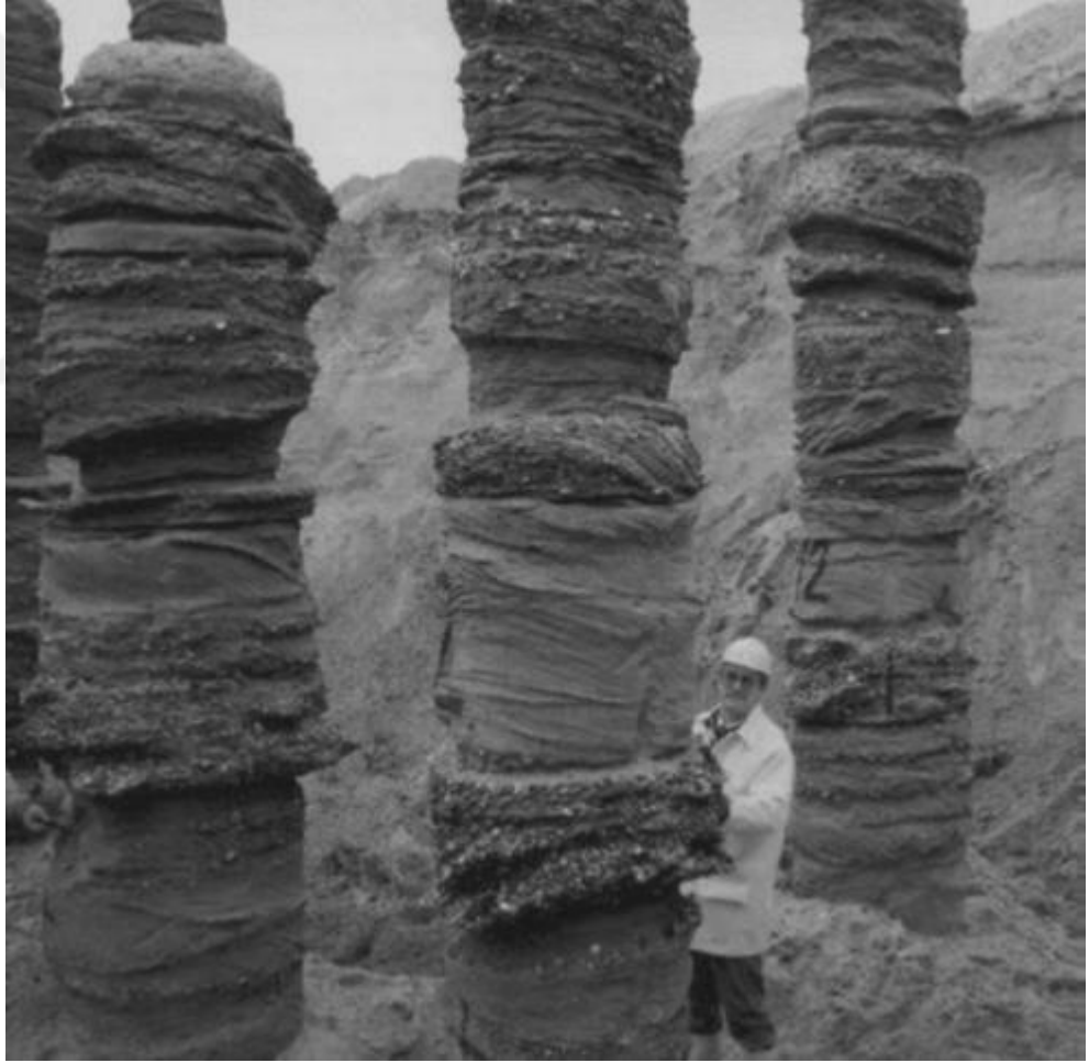
Şekil 3.24 Bilimsel bir çalışma için imal edilen jet grout kolonunun tamamının açığa çıkarılması
