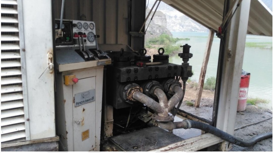
Şekil 3.5 Jet grout sistemine ait basıncı üreten motor ünitesi
