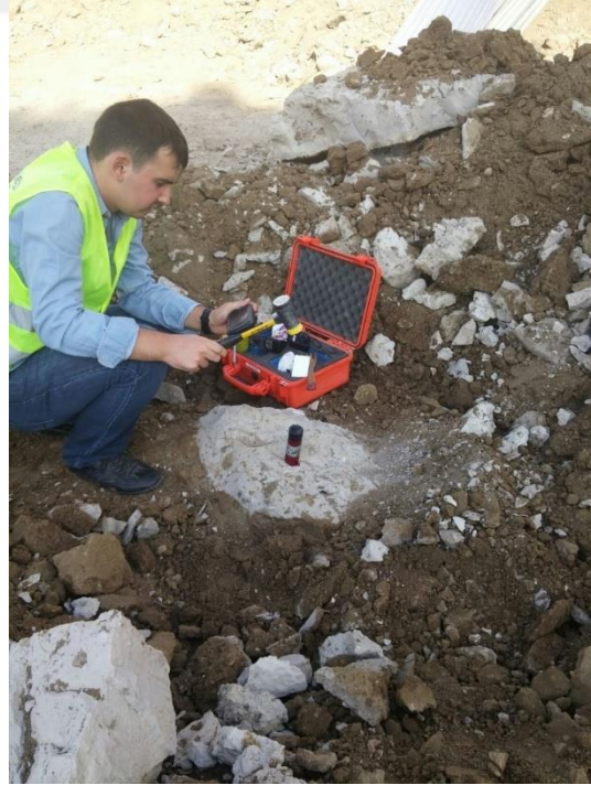
Şekil 3.26 Pile Integrity Test ile jet grout kolonunda ölçüm yapılması
