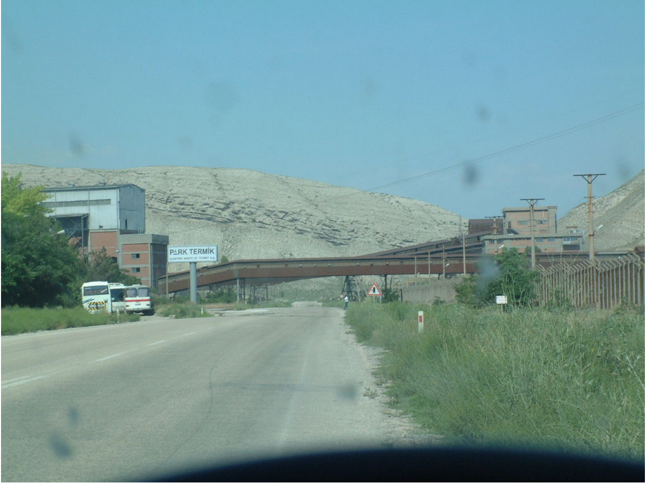
Şekil 2. Çayırhan termik santrali kömür nakil bant hattı
