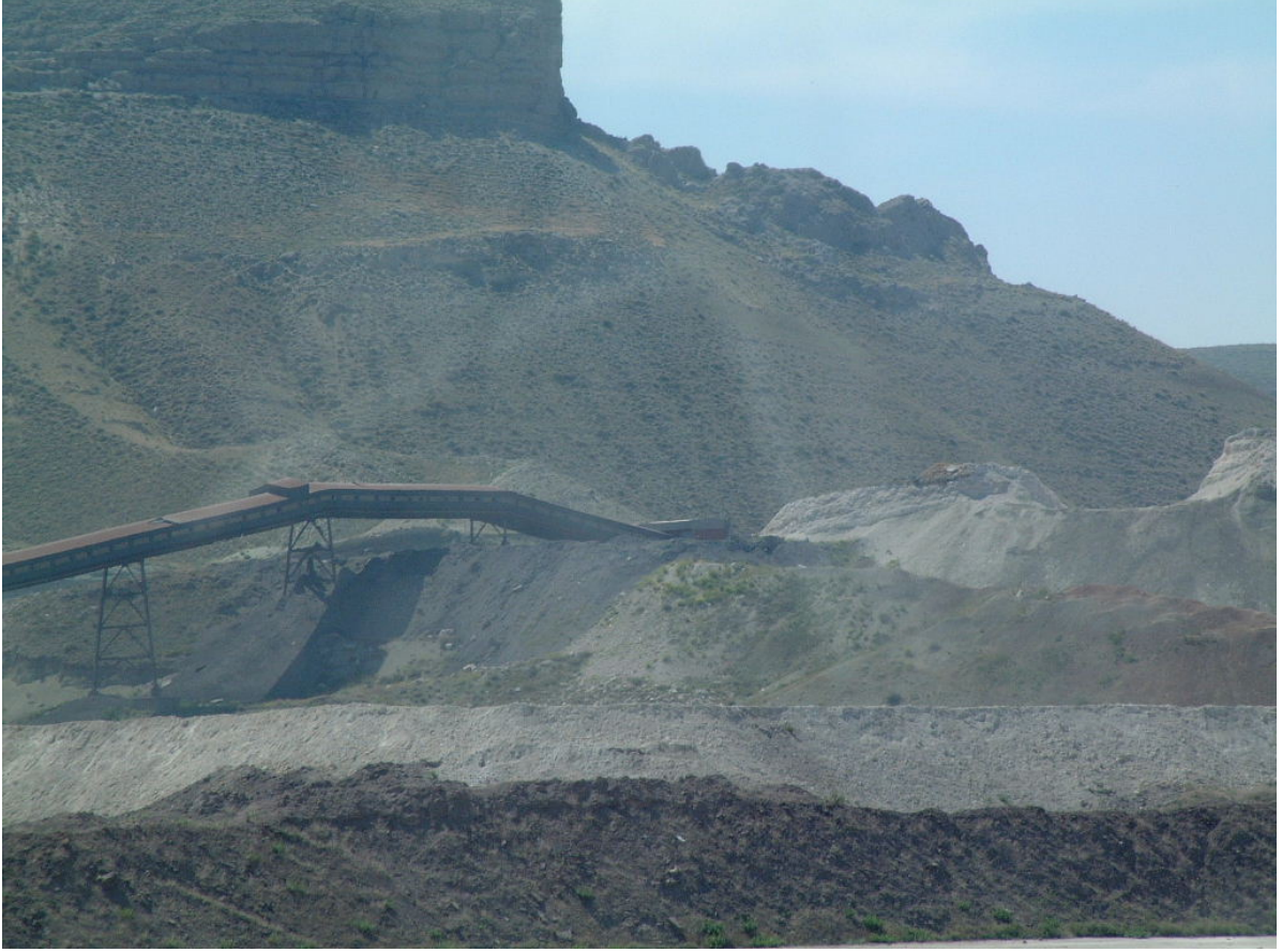
Şekil 32. Çayırhan termik santrali kül nakil bant hattı
