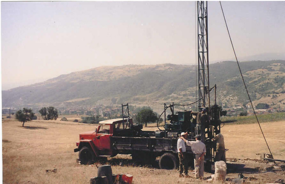
Şekil 6. S5 no.lu jeoteknik sondajın yapılmasından görünüş.
