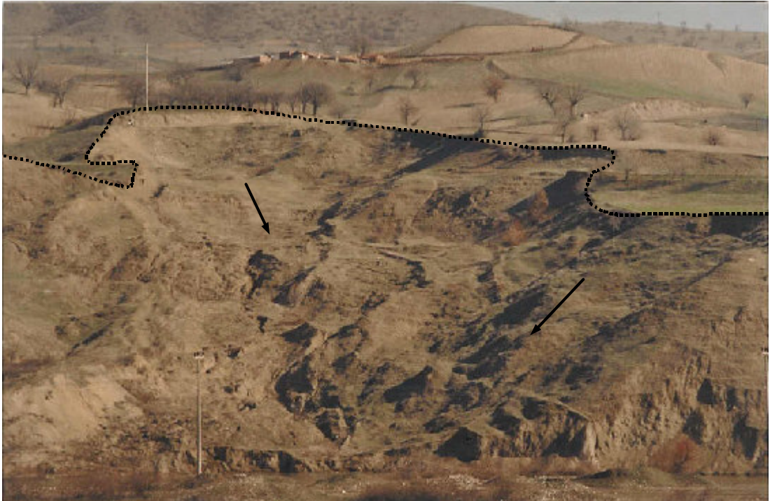
Şekil 10. Yeşilırmağın topuktan yük alması ile oluşan VI numaralı heyelan (GB' dan KD' ya bakış)
