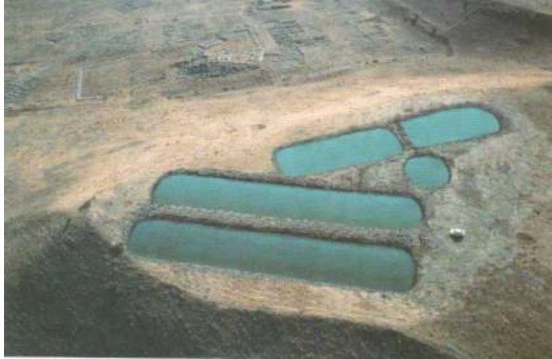
Resim 16: Yukarı Şehir Güney Havuzları
