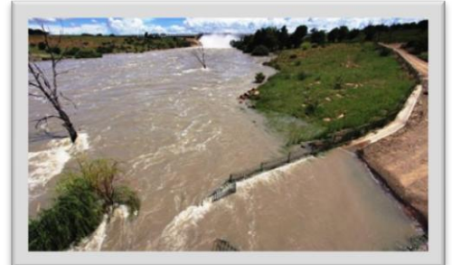
Johannesburg yakınlarındaki Vaal Barajı taşkını
