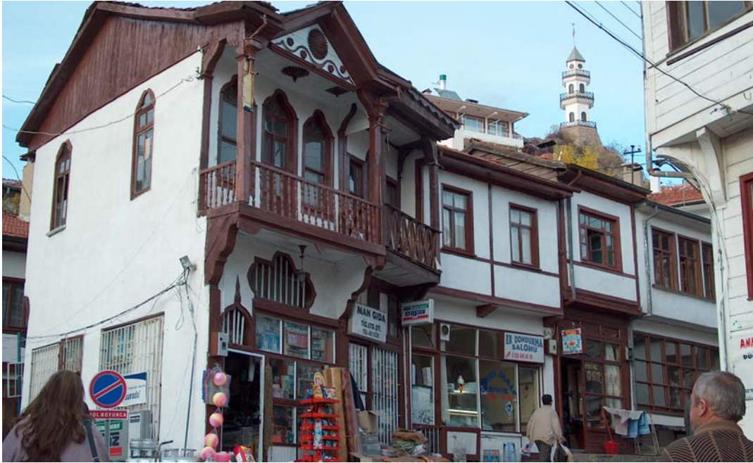
Şekil 4.40. Dış cephede ahşap kullanımı (Arslan 2004)
