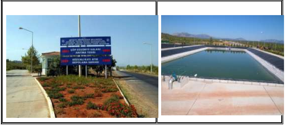
Şekil 5.9 Kızıllı Katı Atık Depolama Tesisi
