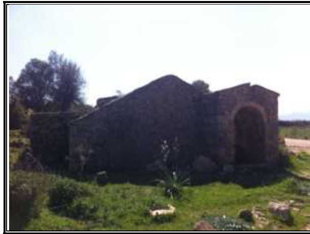
Şekil 5.10 Çalışma alanında bulunan tescilsiz bir kültür varlığı (a)
