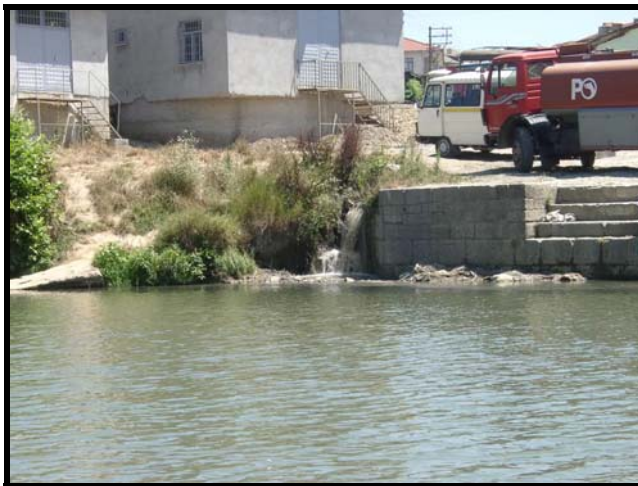
Şekil 5.7 Bartın kenti kanalizasyonunun Bartın Çayı'na deşarj edildiği nokta (Orijinal 2005)
