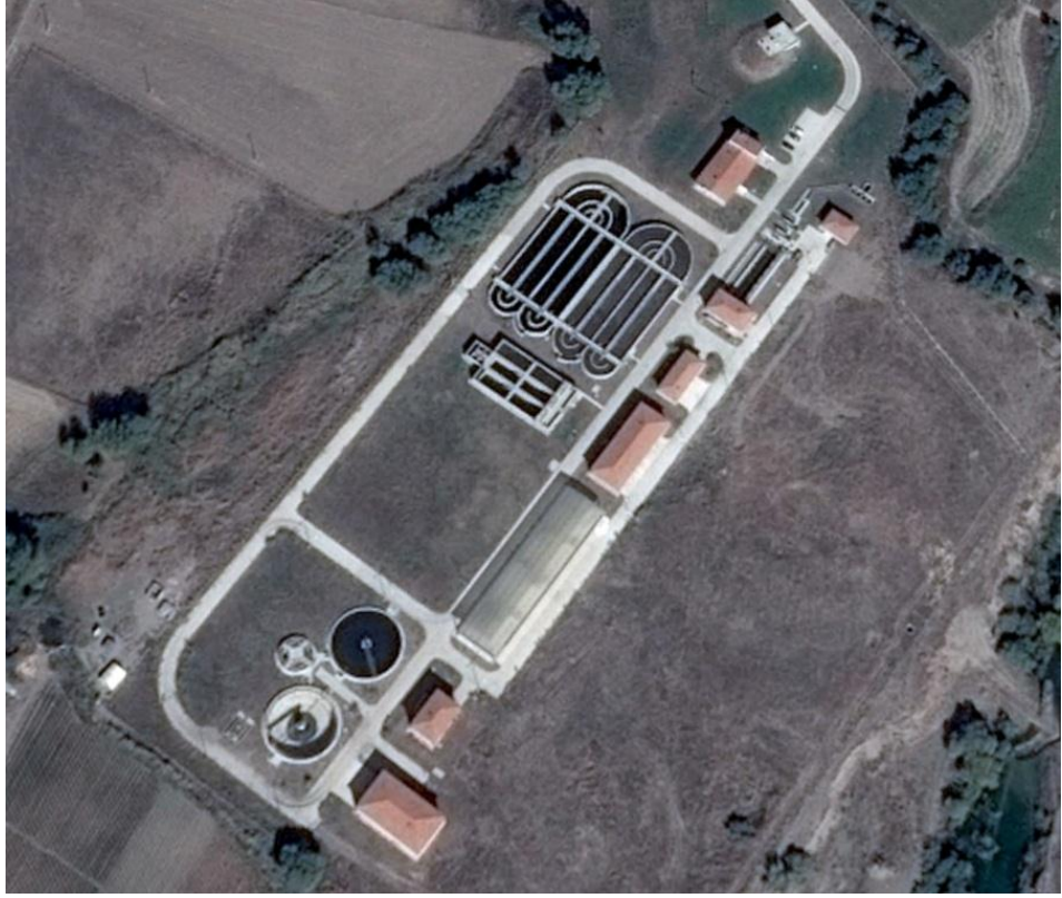
Şekil 3.16 Ankara Kazan atıksu arıtma tesisi
