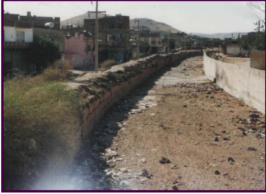
Foto 27. Şanlıurfa'nın Çok Defa Sellere Maruz Kalmasına Neden Olan Karakoyun Deresi'nin Yatağını Değiştirmek Amacıyla İnşa Edilen Justinien Bendi. (M.S. Şahinalp, 2003).
