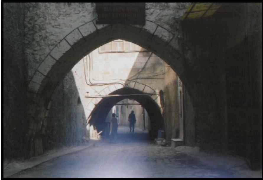
Foto 8. Şanlıurfa'da Tarihi Sokaklarda Geçişleri Sağlayan Kablar . (M.S. Şahinalp, 2003).
