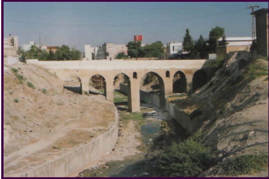
Foto 26. Şanlıurfa'da Karakoyun Deresi Üzerinde Yer alan Köprülerden Ali Saip Köprüsü. (M.S. Şahinalp, 2003)
