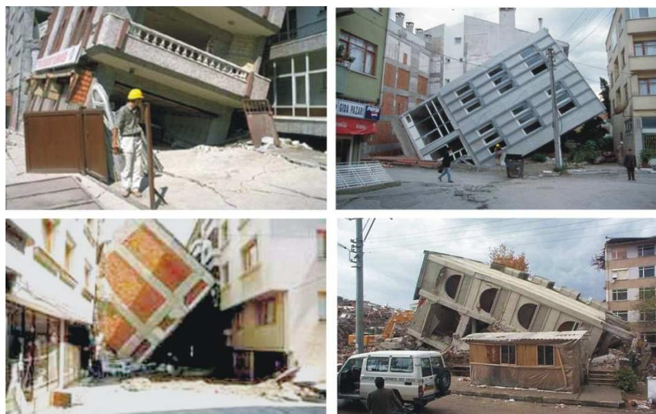
Şekil 1.1 17 Ağustos 1999 İzmit depreminde Adapazarı’nda sivilaşmaya bağlı olarak meydana gelen hasarlar
