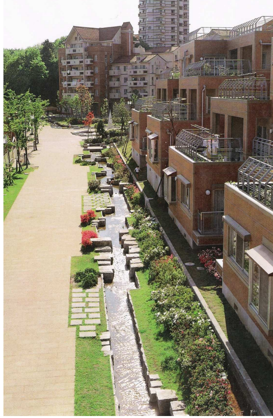
Şekil 4.9 Bell Colline Minami Osawa, Tokyo (Murotani 1992)
