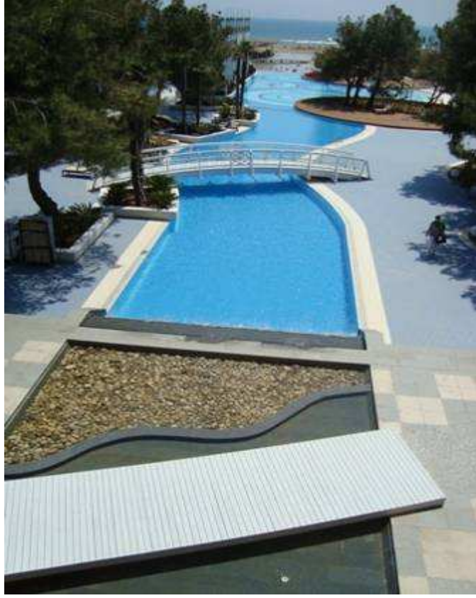
Şekil 4.18 Köprüçay ana havuz bağlantısı ve ahşap köprüler (Orijinal 2009)
