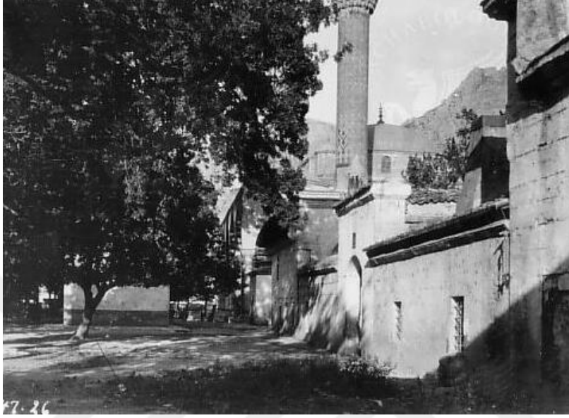
Fotoğraf 104. Medrese Avlu Giriş Portalı, Muvakkithane, Cami ve Medrese Arasında Kalan Yapı (1926) 306
