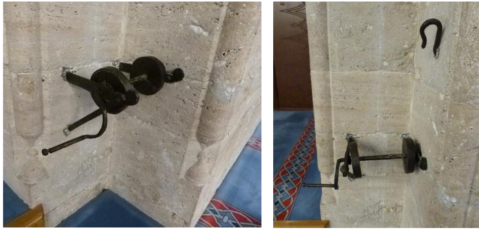
Fotoğraf 20. Cami Kandillerinin Yakılıp Söndürülmesi İçin Kullanılan Makara (2022)
