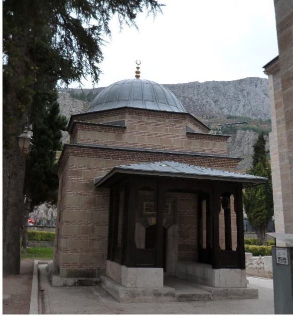
Fotoğraf 90. Amasya Şehzade Osman Türbesi Dış Cepheden Görünüşü (2022)
