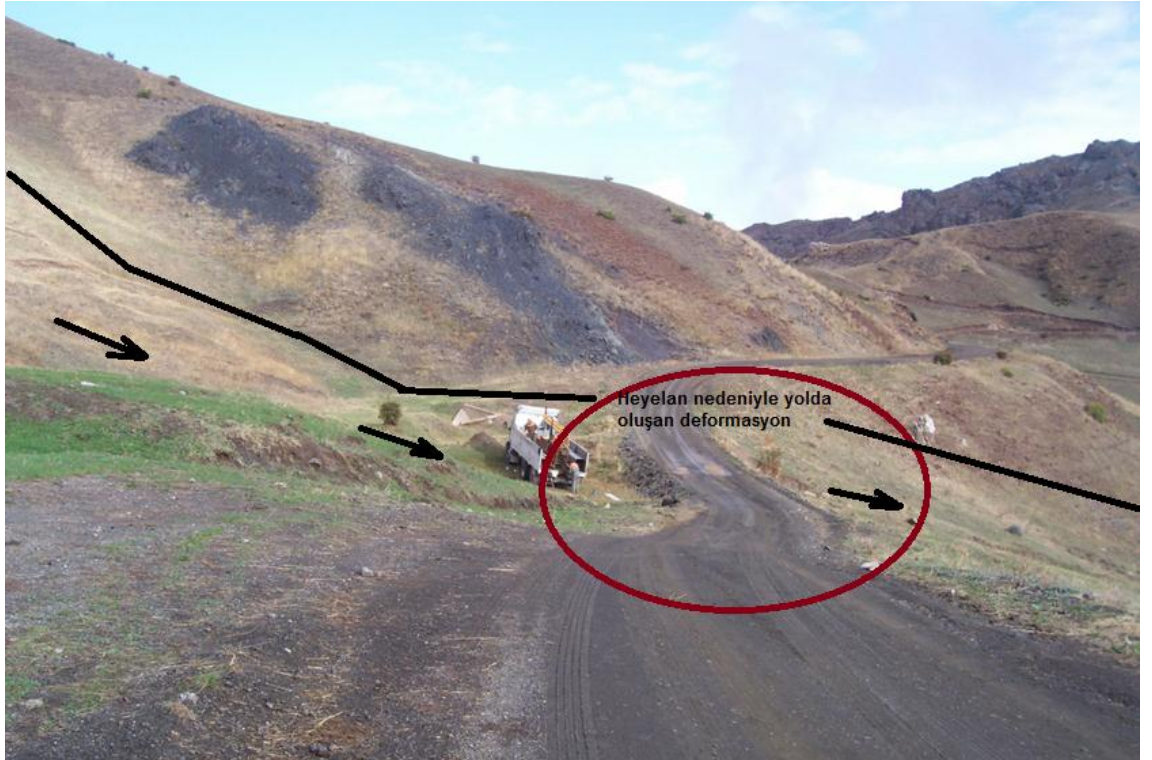
Şekil 5.62 H.4 heyelanının yolda oluşturduğu deformasyon (güneyden kuzeye bakış)
