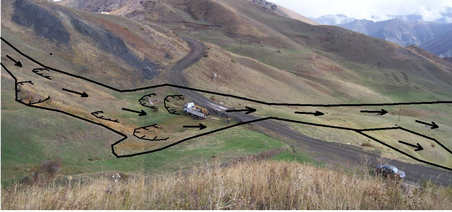
Şekil 5.5 Km: 83+880-83+940 arası heyelanının (H.4) arazideki görünümü (güney batıdan kuzey doğuya bakış)
