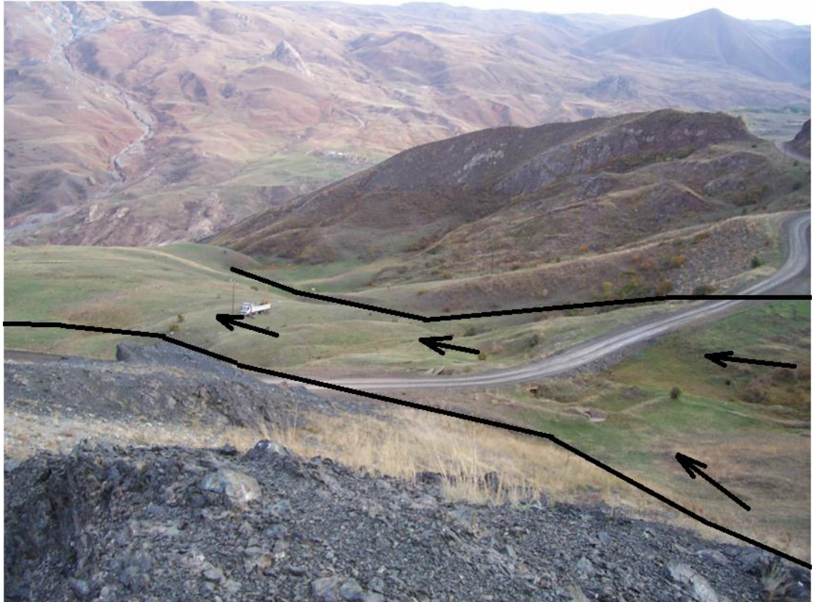
Şekil 5.59 H.4 No.’lu heyelanın görünümü (kuzeybatıdan güneydoğuya bakış)
