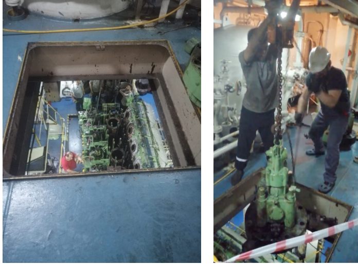
Fotoğraf 39-40: Caraskal ile Ana Makine Parçalarının Çekilmesi, 2021
