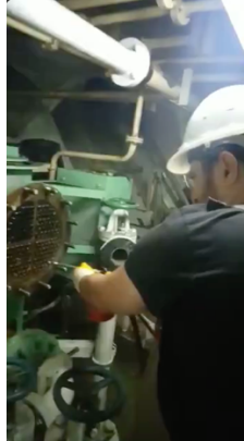
Fotoğraf 41: Makine Dairesinde Evaporatör Temizliği, 2021
