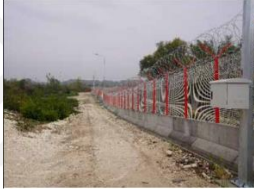
Fotoğraf 11: Türkiye-Yunanistan Sınırına İnşa Edilen Panel Çit, Trafo ile Enerji Nakil Hatları ve Kamera ile Aydınlatma Sistemleri 340
