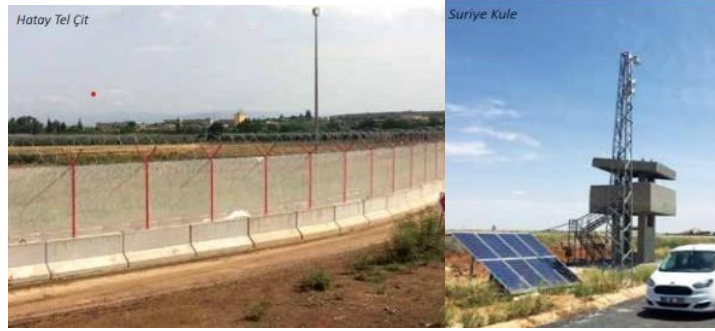
Fotoğraf 6: Sınırlarda Yer Alan Tel Çitli Modüler Beton Duvarlar ve Gözetleme Kuleleri 329
