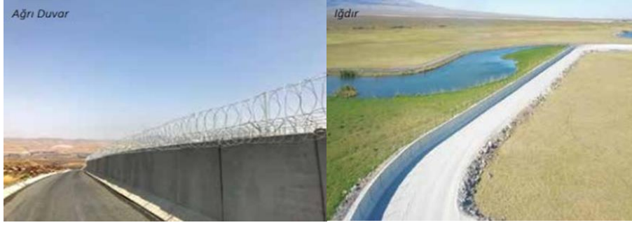
Fotoğraf 7: Ağrı ve İğdir Sınır Hattına Yapılmış Olan Modüler Beton Duvarlar ve Devriye Yolları 332
