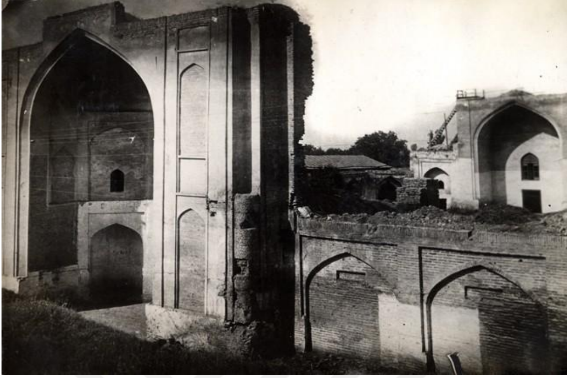
Resim 6: Barakhan Medresesinin restoreden önceki durumu (1940)
