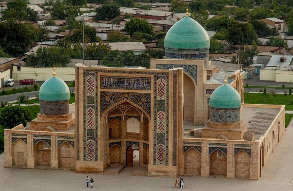
Resim 7: Barakhan Medresesinin 2007'deki durumu
