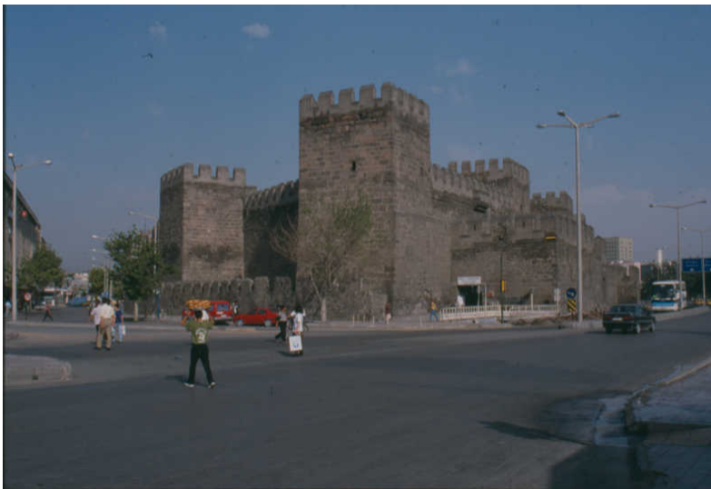
Şekil 4.18. Kayseri Kalesi surları (Somuncu 1998).
