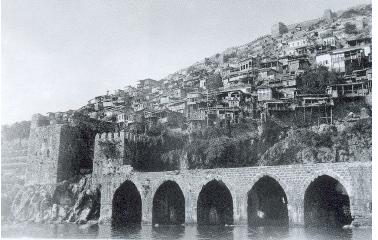
Levha 96: Alanya-Tersane Binası ve Tophâne Mahallesi'nden görünüş
