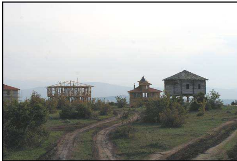
Şekil 4.40. Kastamonu Doğa ve Kültür Köyü Açık Hava Müzesi'nden genel görünüş
