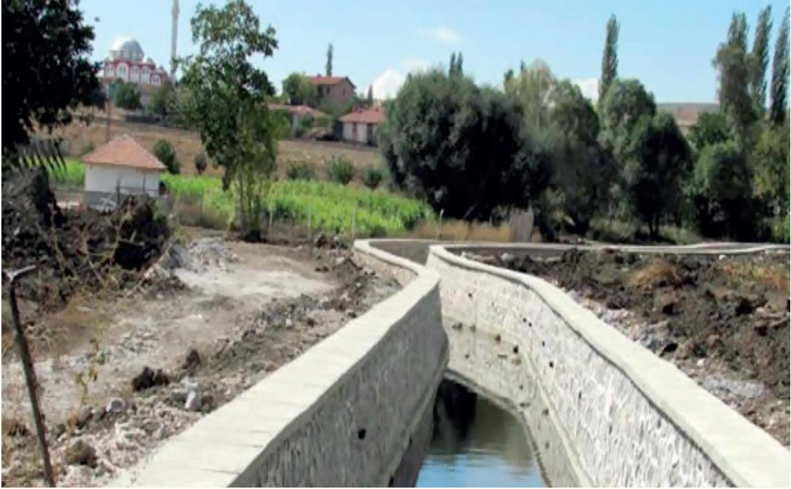
Şekil 14. Taşkın Koruma Amacıyla Bartın'da İnşa Edilen Bir Taşkın Duvarı (SYGM, 2022)
