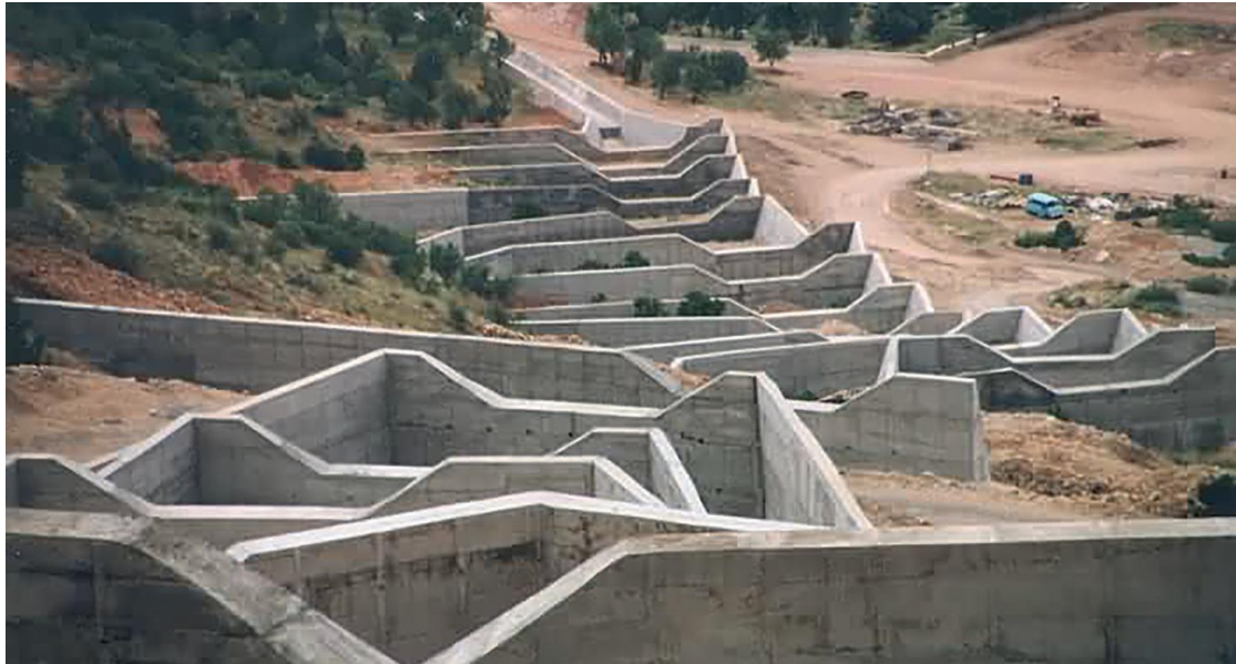
Şekil 16. Taşkın Koruma Amacıyla Isparta'da İnşa Edilen Bir İslah Sekisi (SYGM, 2022)
