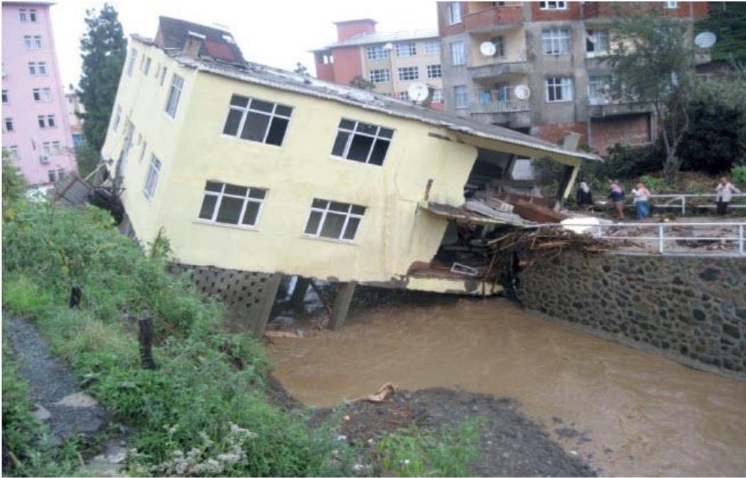
řekil 6. Akarsu Yataęına İnřa Edilen Yapı Örneęi-Rize (SYGM, 2022)
