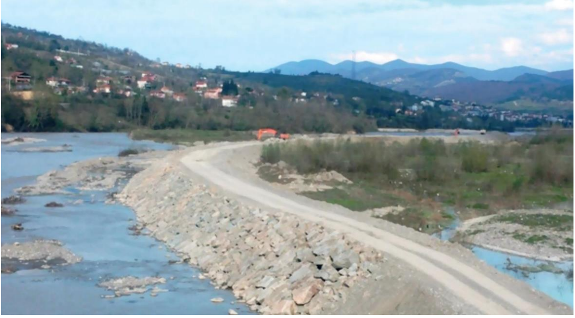
Şekil 13. Taşkın Koruma Amacıyla Zonguldak'ta İnşa Edilen Bir Sedde (SYGM, 2022)
