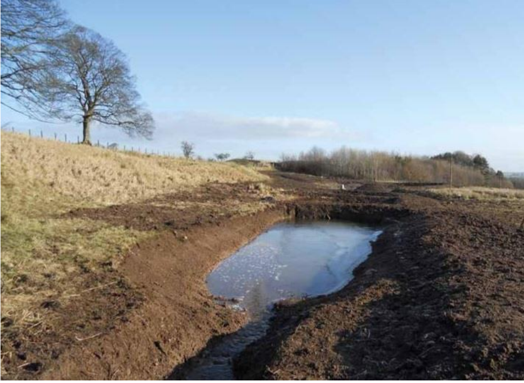
Şekil 21. İskoçya’da Bir Karasal Çöküntü Tuzağı Örneği (Scottish Environment Protection Agency, 2015)
