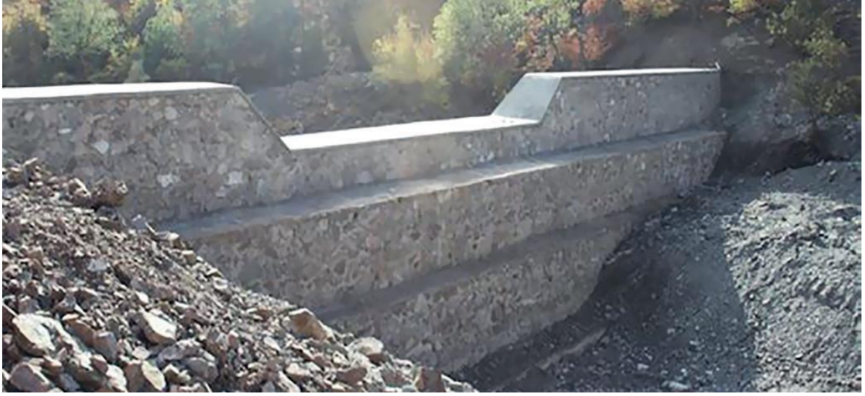
Şekil 17. Taşkın Koruma Amacıyla Tokat'da İnşa Edilen Bir Tersip Bendi (SYGM, 2022)
