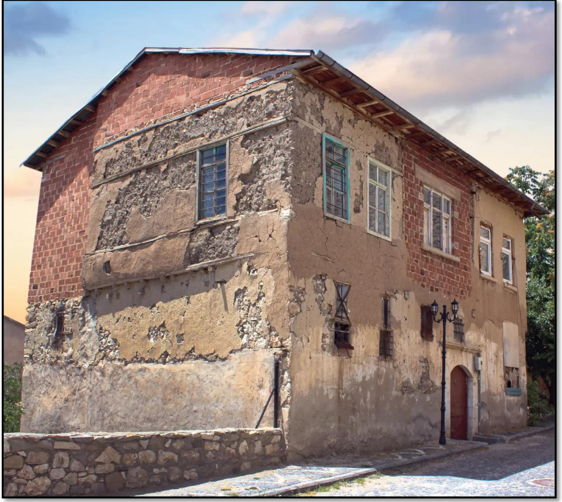
Şekil 4.99 Tescili yapılmış ancak restorasyon görmemiş harap durumdaki telgrafhane binası (Anonim, 2021w)
