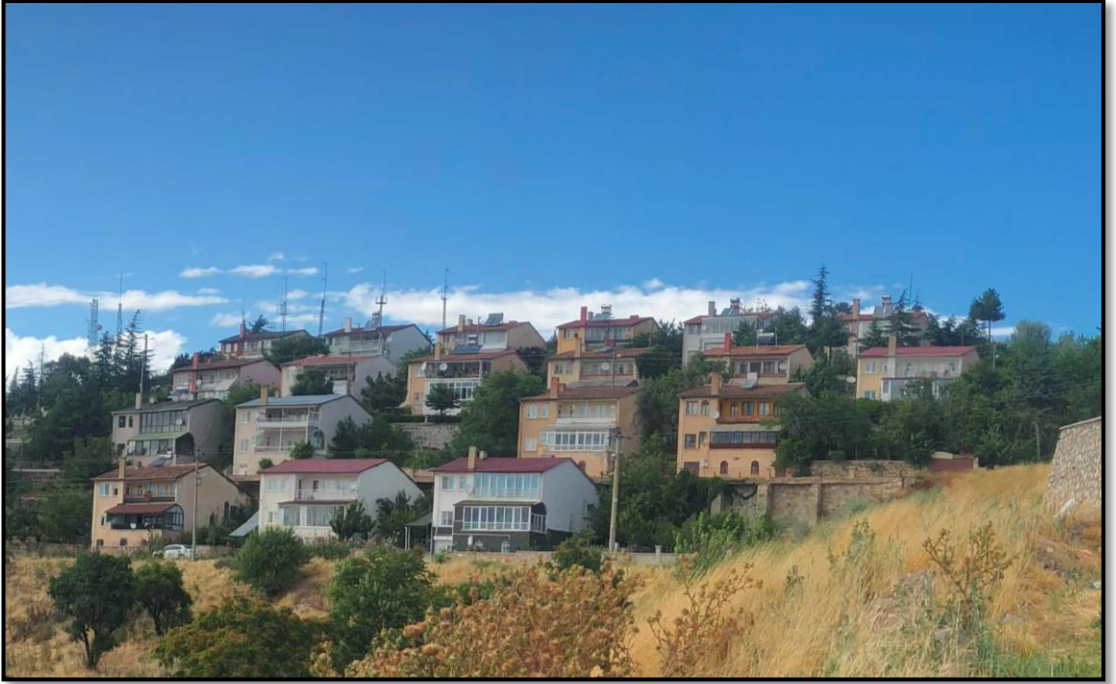
Şekil 4.98 Geleneksel konut dokusu ile uyumsuz betonarme yapılar (Orijinal, 2023)
