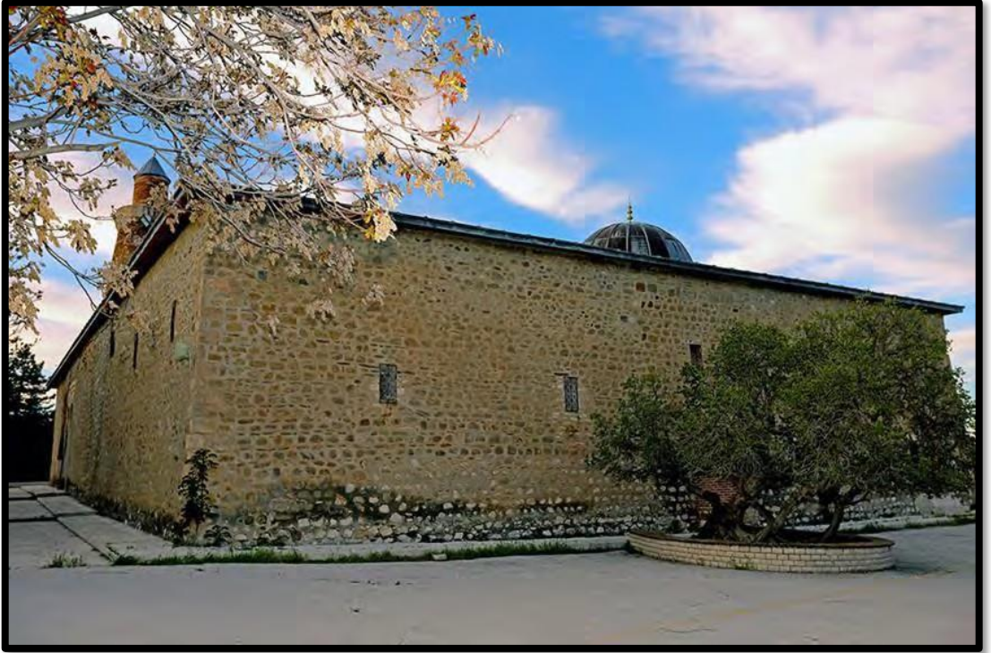
Şekil 4.42 Ulu Camii arka cephesi (Anonim, 2023e)
