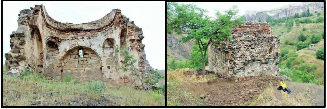
Şekil 4.45 Dabakhane Mescidi restorasyon öncesi hali (Anonim, 2021h)
