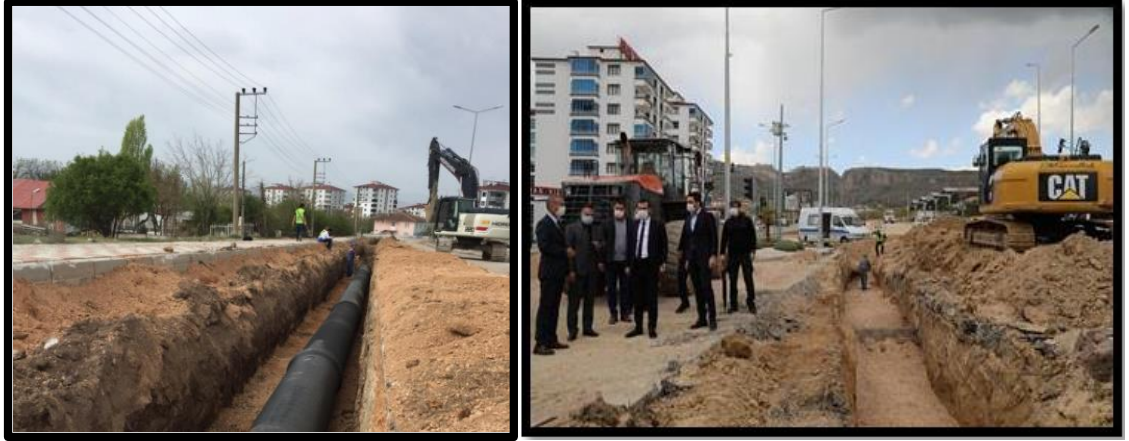
Şekil 4.80 Kanalizasyon, içme suyu, drenaj ve yağmur suyuna yönelik alt yapı çalışmaları (Anonim, 2022i)
