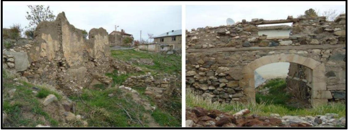
Şekil 4.68 Geleneksel Harput evlerine ait duvar kalıntıları (Özdemir ve Özdemir Çetiner, Fotoğraf arşivi, 2014)
