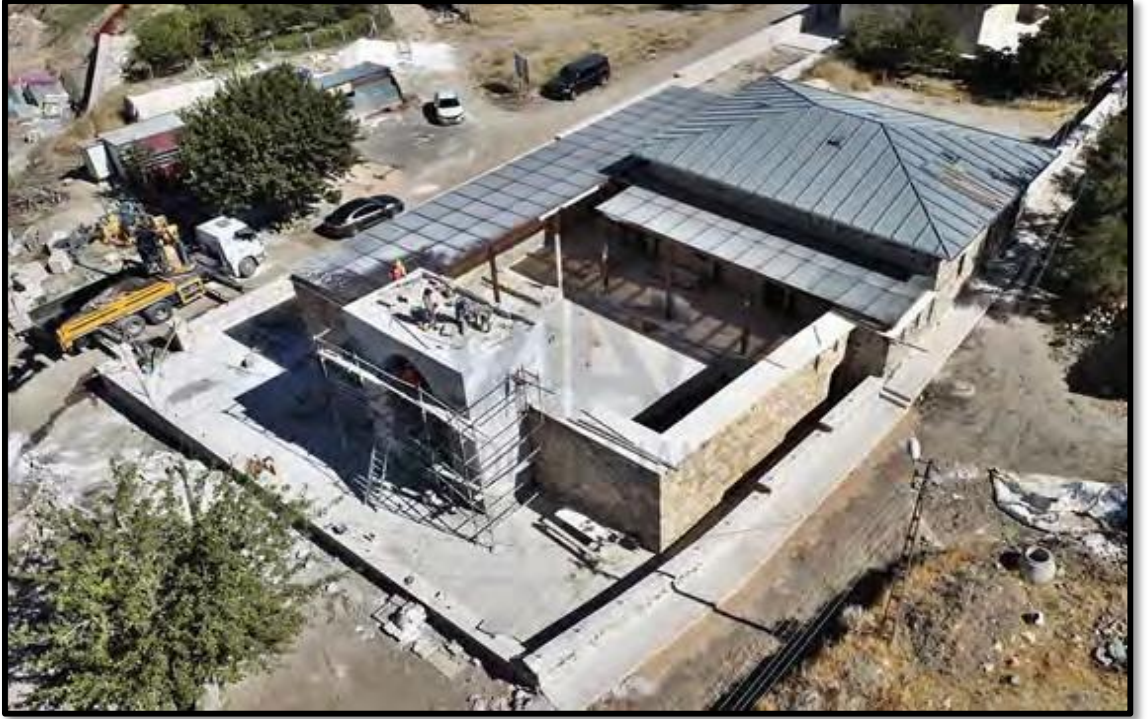
Şekil 4.40 Esadiye (Arslanlı) Camii restorasyon çalışmaları (Anonim, 2021d)
