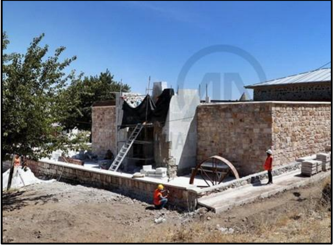
Şekil 4.39 Esadiye (Arslanlı) Camii restorasyon çalışmaları (Anonim, 2021d)
