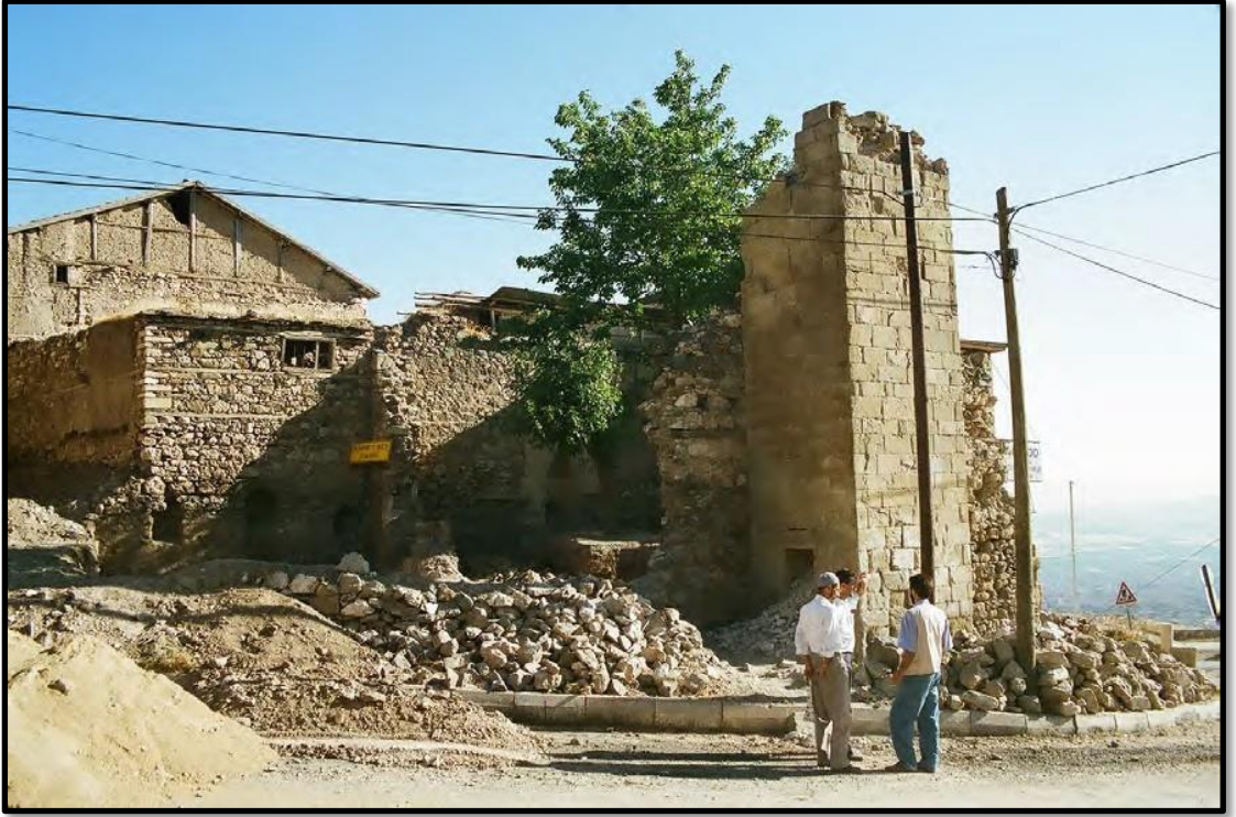
Şekil 4.31 Ahmet Bey Camii restorasyon öncesi görünüm (Anonim, 2021b)
