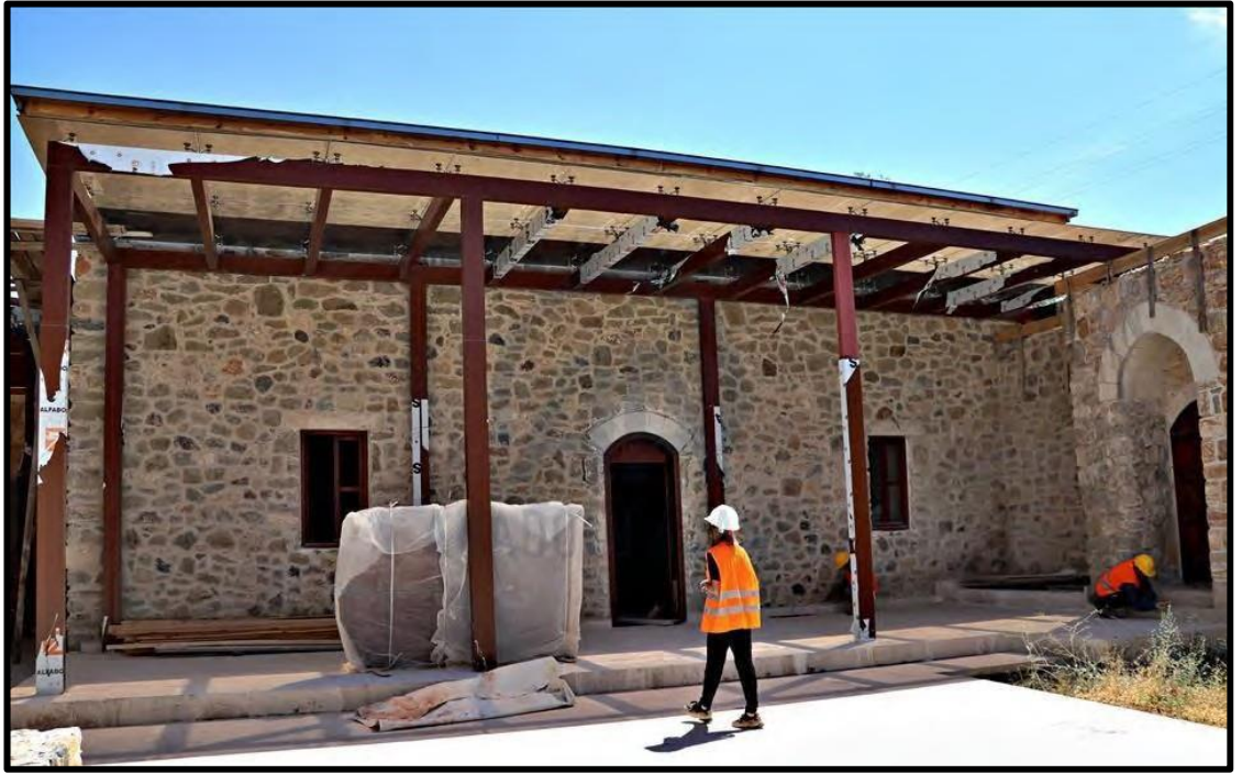
Şekil 4.38 Esadiye (Arslanlı) Camii restorasyon çalışmaları (Anonim, 2021d)
