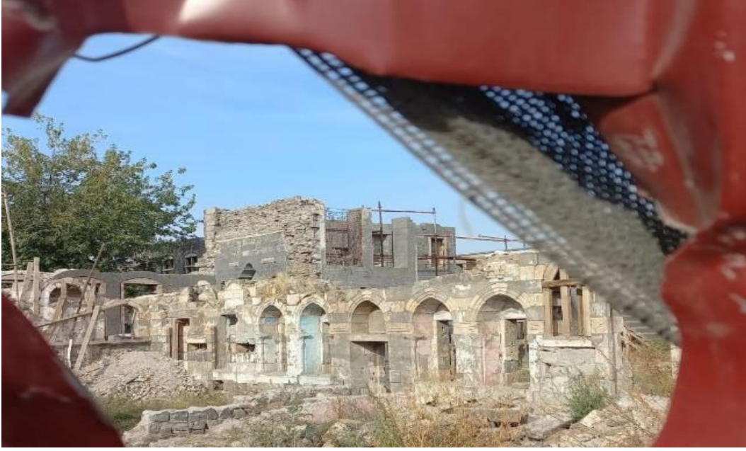
Foto 1: Sit Alanında Kentsel Dönüřüm
