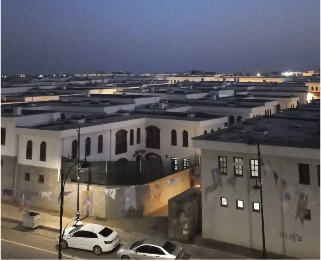
Fotoğraf 6: Suriçi'nde inşa edilen yeni yapıların gece görünüşü
