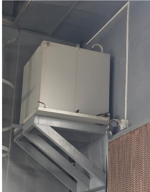
Şekil 3.11 Yakıt deposu ve filtresi
