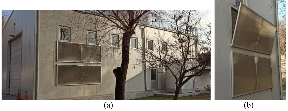
Şekil 3.14 Petek kapakları kapalı konumda (a), açık konumda (b)
