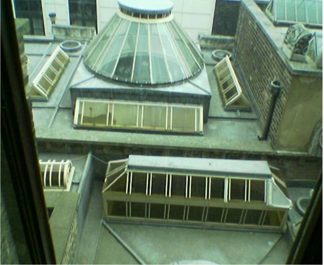
Foto 201- Tepe aydınlatmaları görünüm. (Meltem Giray)
