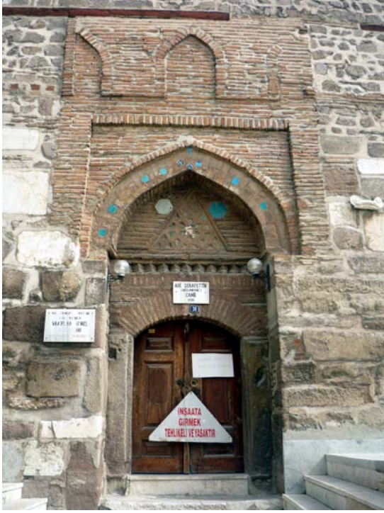
174.Resim:Arslanhane Cami doğu kapısı
