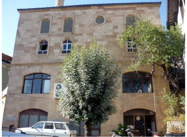
42. Resim:Beypazarı Akşemseddin C. kesme taş duvarları
