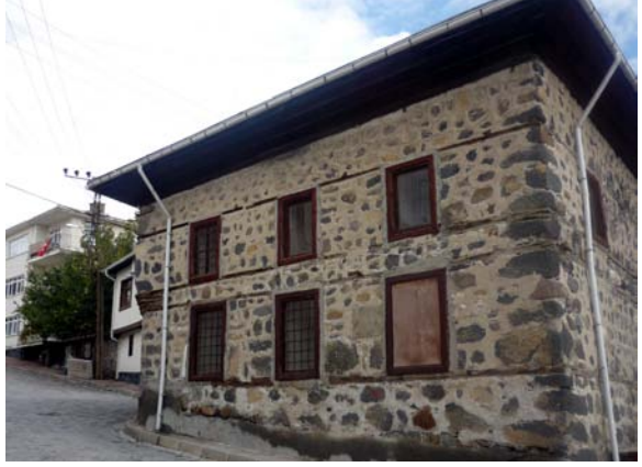
77.Resim: Ayaş Aktaş Cami ahşap hatıl
