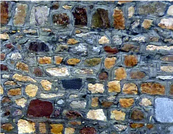
142.Resim: Tabduk Emre Türbesi tuğla malzeme
