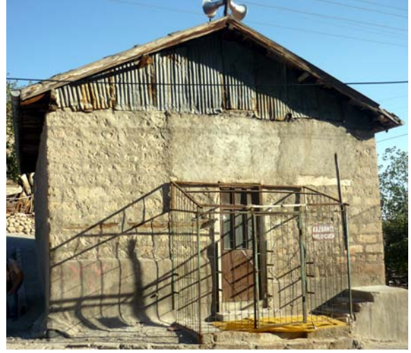
153.Resim: Beypazarı Kazgancı Mescidi kuzey cephe
