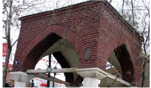
137. Resim: Kesikbaş Türbesi tuğla işçiliği
