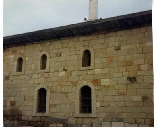
34.Resim: Kalecik Tabakhane Cami taş duvarları
