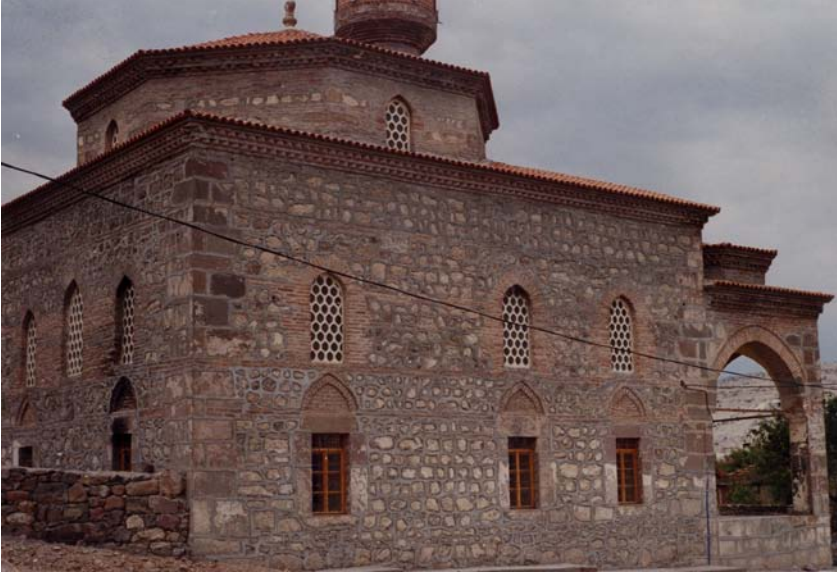
43.Resim:Çamlıdere Peçenek Köyü Cami taş-tuğla duvarları(VGM'den)
