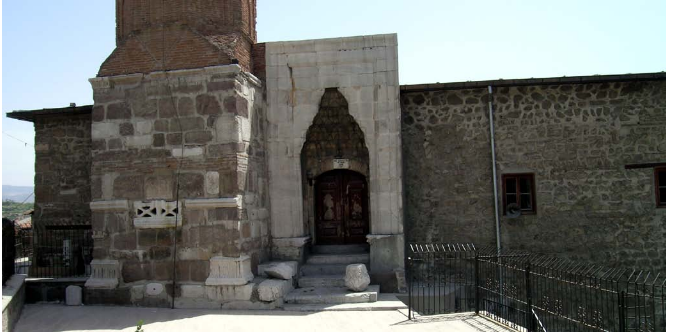
25.Resim: Arslanhane Cami kuzey portalı ve minare kaidesinde taş malzeme kullanımı
