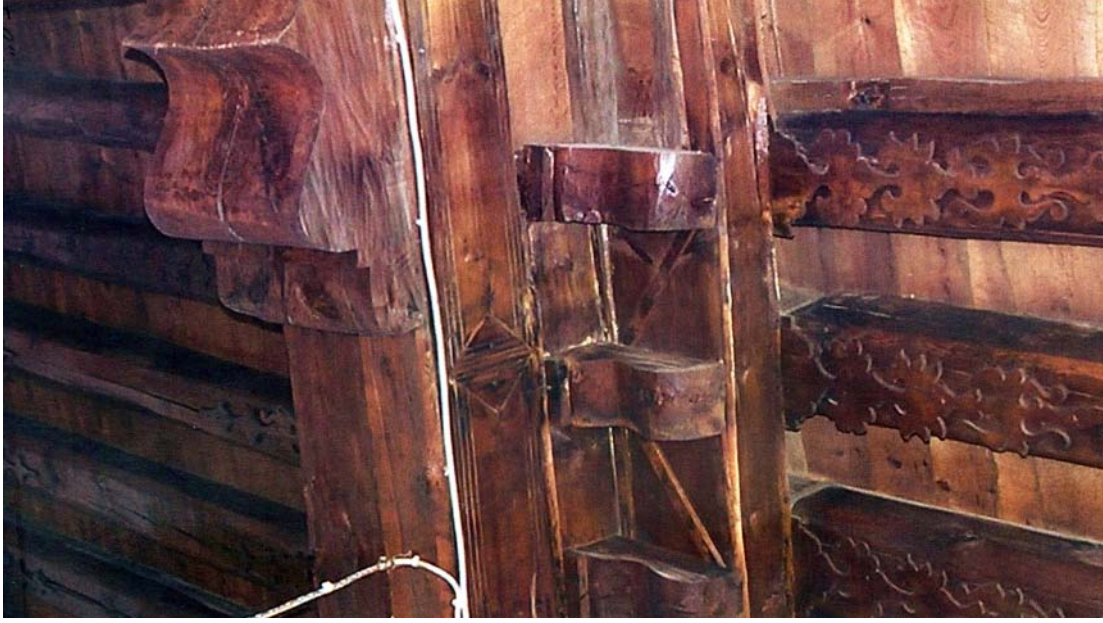
68.Resim: Hacı İvaz Cami son cemaat mahalli tavanı
