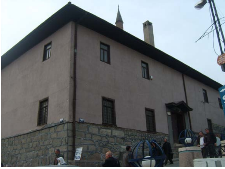
149.Resim:Ahi Elvan Cami cephe
