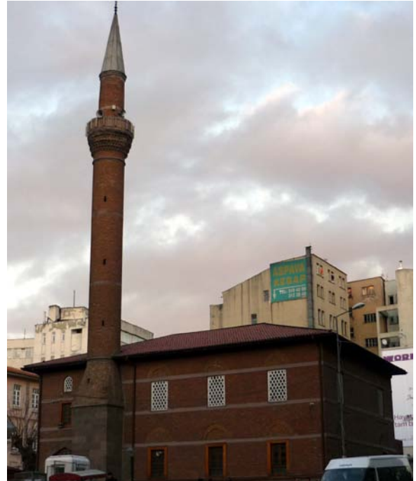
49. Resim: Zincirli Cami tuğla duvarları
