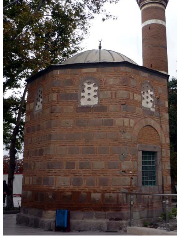
117 . Resim: Osman Fazıl Türbesi taş malzeme
