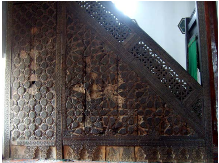
216.Resim: Ahi Elvan Cami minberi merdiven korkuluğu
