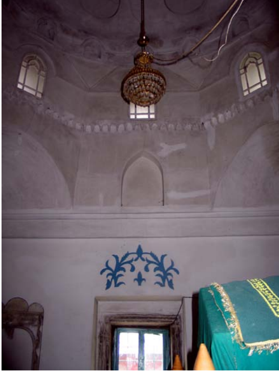
166.Resim.Ahi Şerafeddin T. sivri kemerli sağır nişler, tromplar 167.Resim: Ahi Şerafeddin Türbesi giriş kapısı
