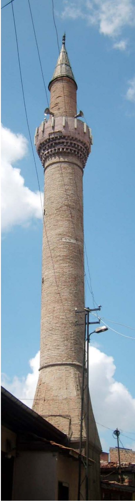
194.Resim: Ahi Elvan Cami minaresi
