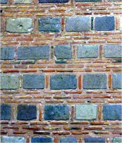
140.Resim: Osman Fazıl Paşa Türbesi tuğla
