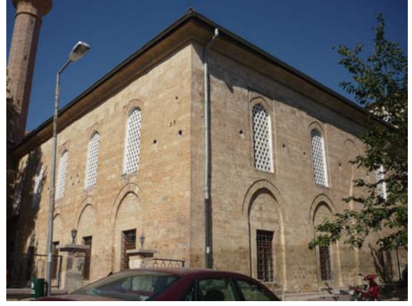
40.Resim:Beypazarı Alaeddin Cami taş duvarları
