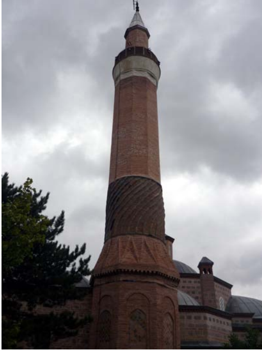
46.Resim:Karacabey Cami tuğla minaresi
