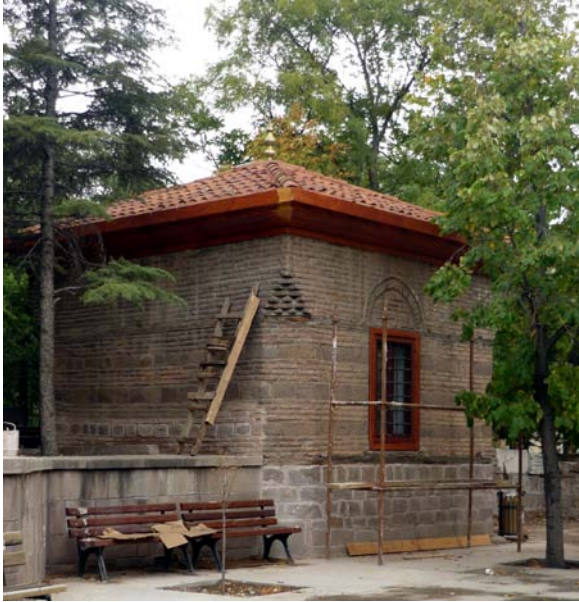
118.Resim: Azimi Türbesi taş malzeme
