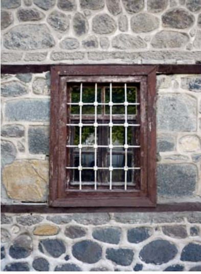
76.Resim: Ayaş Ulu Cami ahşap hatıl
