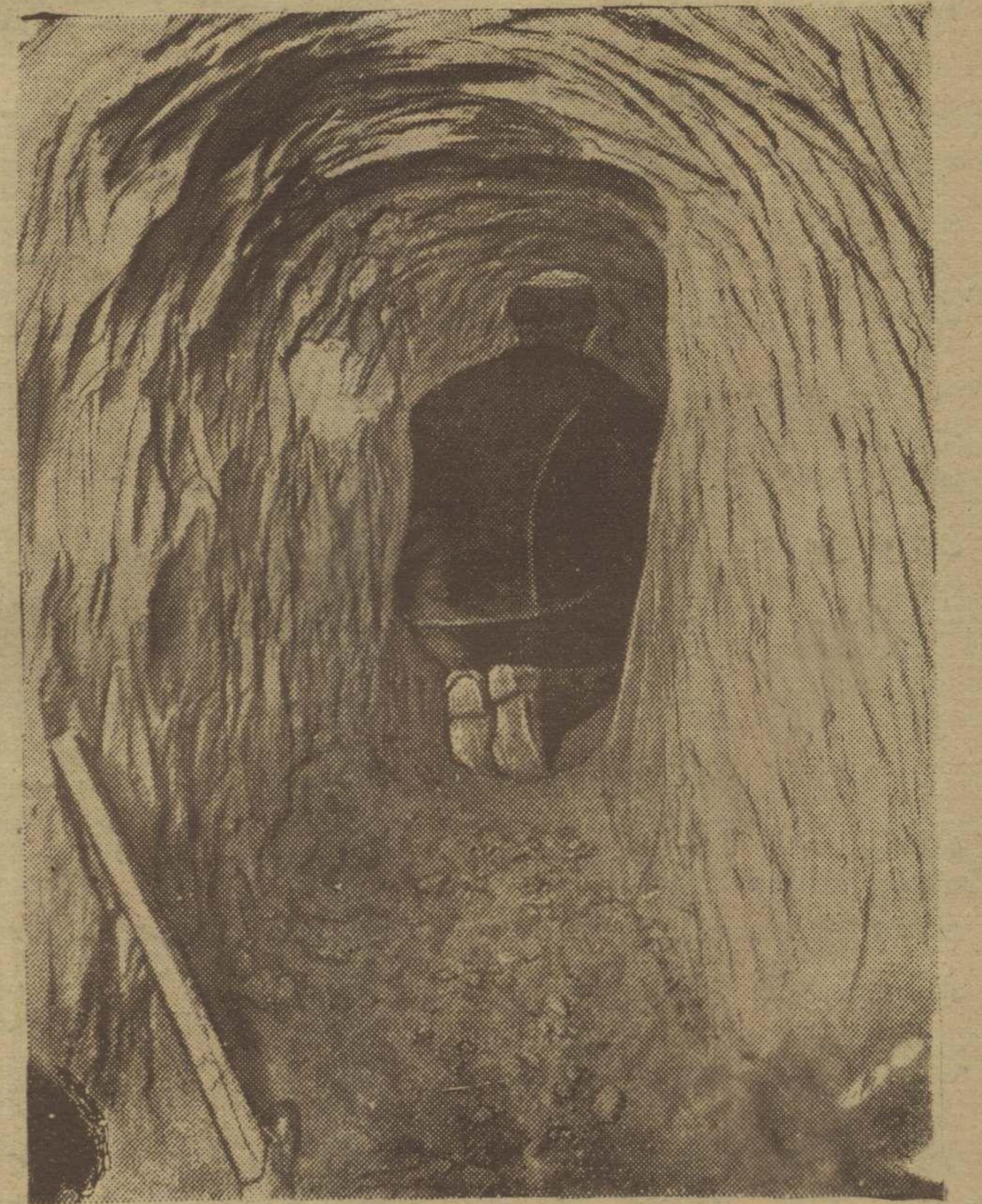
غرب جبهه سنده ، تحت الارض لثم ترتيباتی Travail de mine sur le front de l'ouest.
