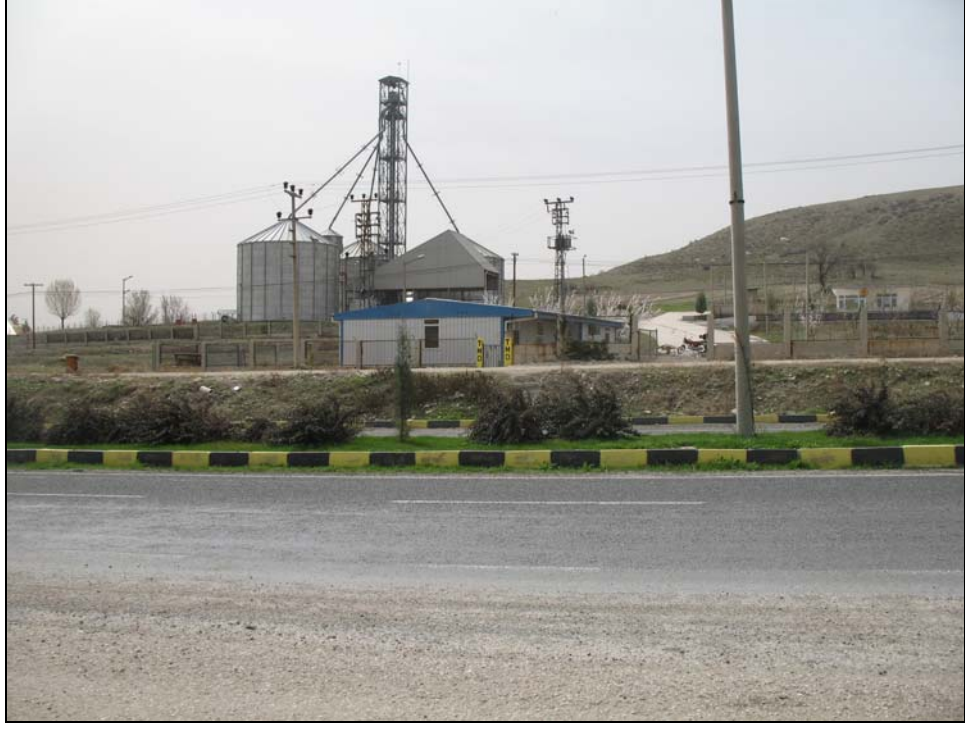
Foto 22. Ankara yolu üzeri Buğday Silosu (TMO)
