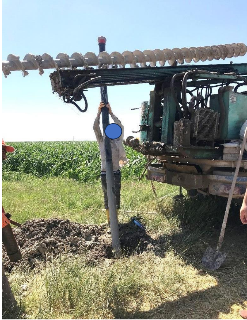
Şekil 2.2 Taban suyu gözlem kuyusu açılışı
