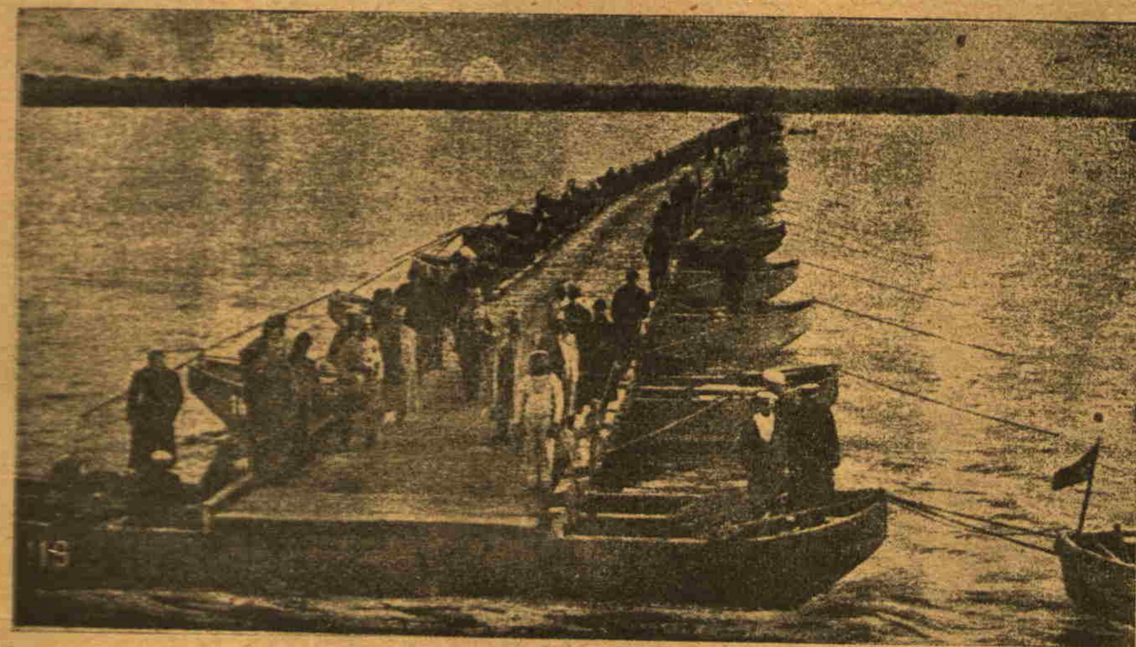
متفقلرک اخیراً چرناودا اوکندنده قارشی یقه یه کچرک مهم بر قسحتی ید ضبطه کچیردکلری طونه نه ری اوزرنده : عسکری کویری Un pont de pontons établi sur le Danube
