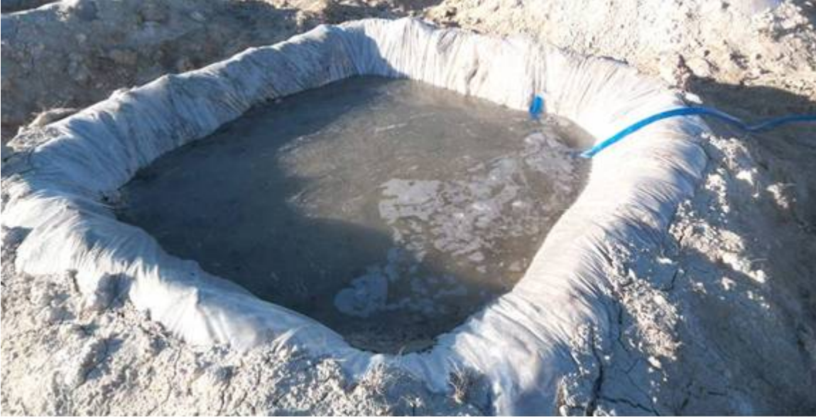
Şekil 3.13 Parsellere yıkama suyunun uygulanması ve aşındırmanın engellenmesi
