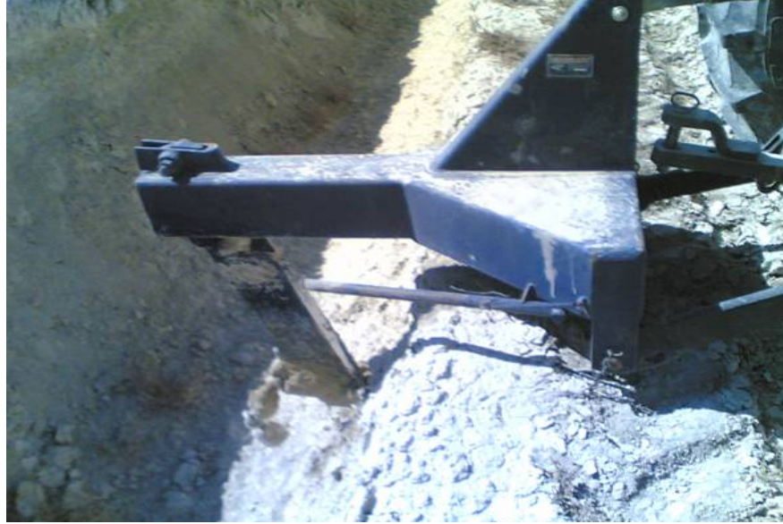
Şekil 3.8 Mol drenajın yapılması
