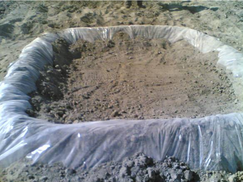
Şekil 3.10 Yıkama yapılacak deneme parseli
