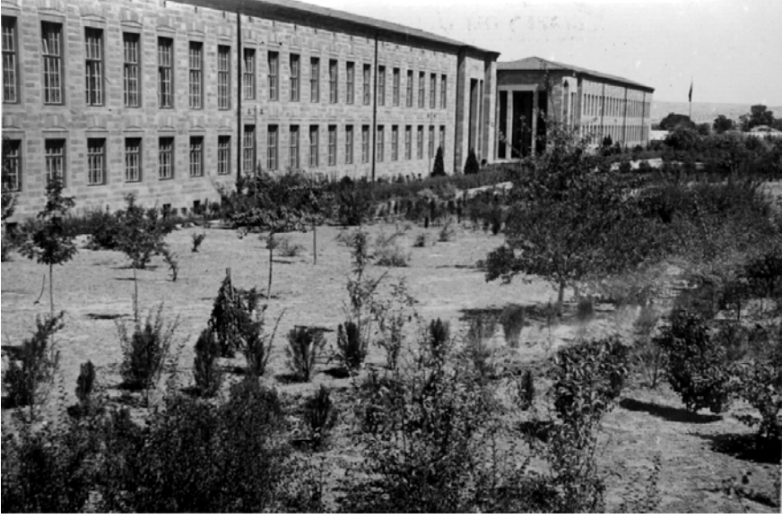
6- Fen Fakültesi Yeni Binasında
