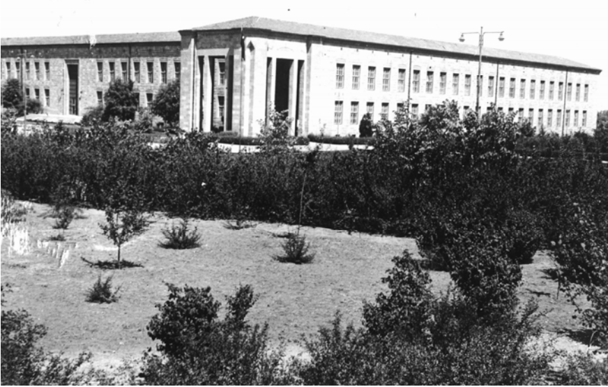
5- Fen Fakültesi Yeni Binasında
