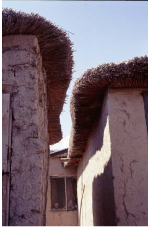
F.26. Çatıda Kullanılan Sazın Saaklardan Çıkan Bölümü
