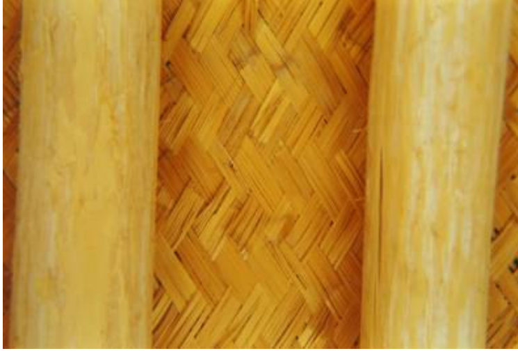
F.28. Niğde/Aksaray Hasırının Evin Tavanında Kullanılışı
