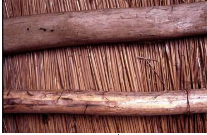
F.25. Çatıda Kullanılan Sazın Ev İinden, Alttan Görünümü
