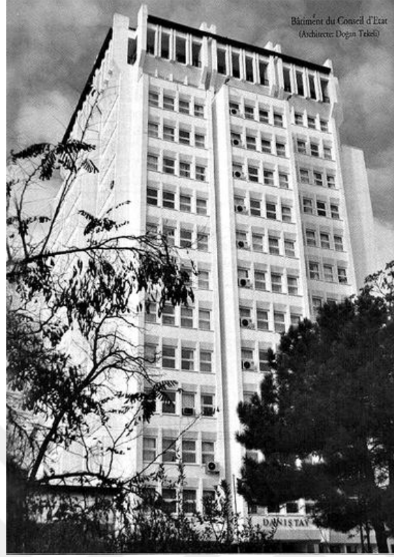
F. 151. (solda) Danıştay Binası (Danıştay Kitapçığından Alınmıştır.)
