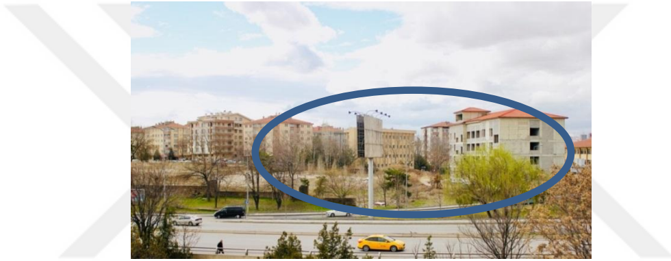
F. 124. Su Süzgeci Binası Arsası, Genel Görünüm, 2020
