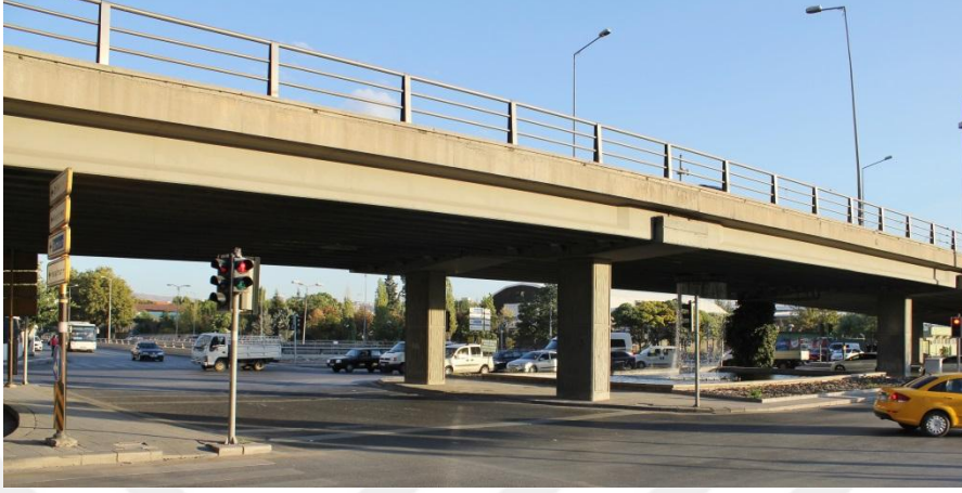
F. 256. Kâzımkarabekir Caddesi ve İstanbul Yolu Kesişimi, Genel Görünüm, 2020
