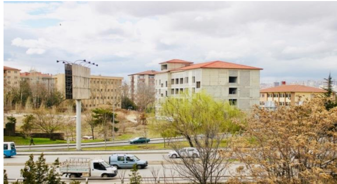
F. 125. Su Süzgeci Binası Arsası, Genel Görünüm, 2020
