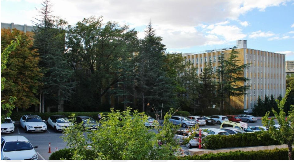
F.15. Hacettepe Üniversitesi Rektörlük Binası, Genel Görünüm, 2020
