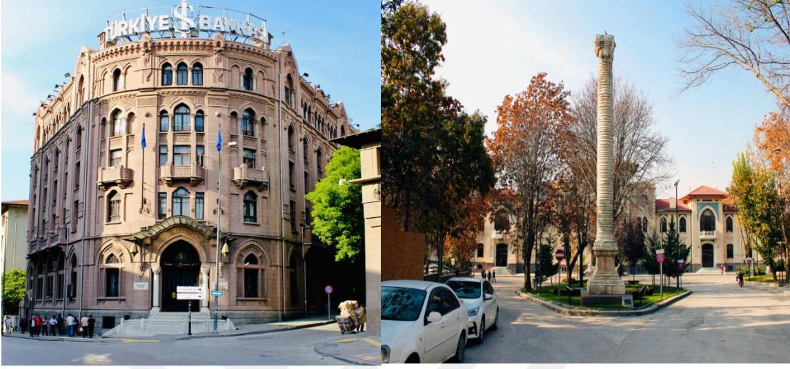
F. 65. (solda) İş Bankası, Genel Görünüm, 2019
