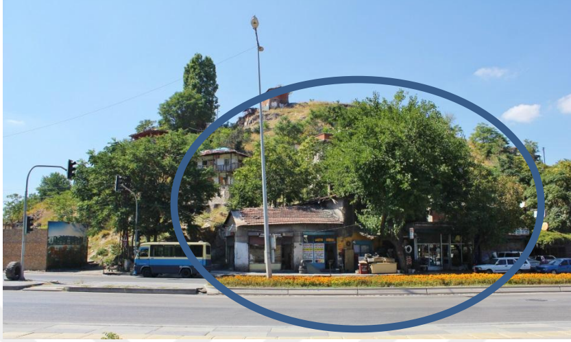
F. 258. Bent Deresi Caddesi, Genel Görünüm, 2020.
