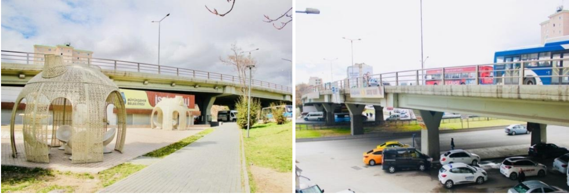
F.253. (solda) Dışkapı Köprüsü, Genel Görünüm, 2020
