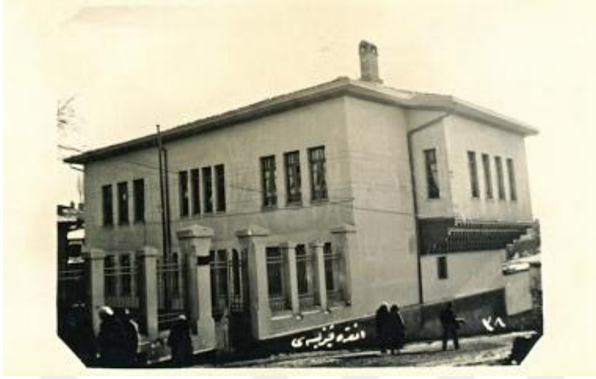
F. 90. Ankara Kız Lisesi İkinci Binası (Yavuz İşçen Arşivi)
