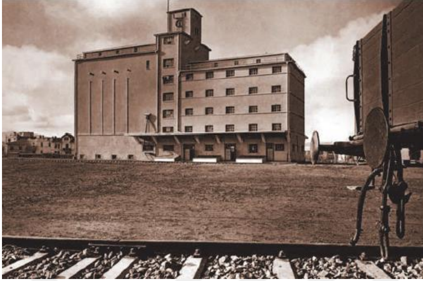
F. 116. (solda) Ankara Silosu (A.Yüksel Arşivi)
