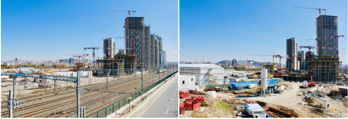
F. 111. (solda) Merkez Ankara İnşaatı, Genel Görünüm, 2020
