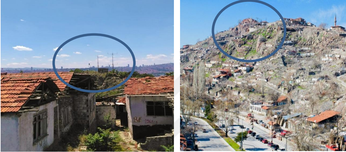
F. 52. (solda) Hıdırlık Tepesi, Genel Görünüm, 2019
