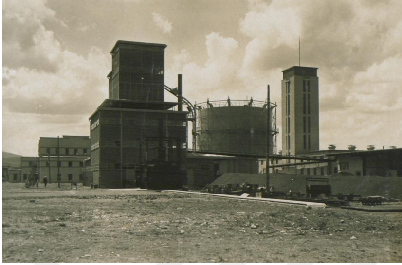
F. 113. Elektrik ve Hava Gazı Fabrikası (Koç Üniversitesi VEKAM Arşivi)
