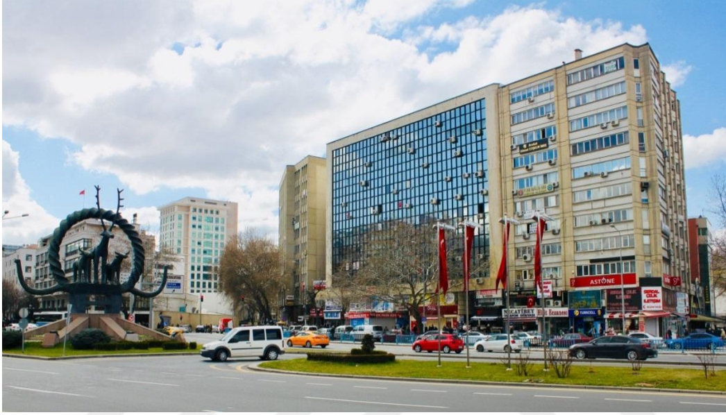
F. 228. Balıkçioğlu İş Merkezi, Genel Görünüm, 2020
