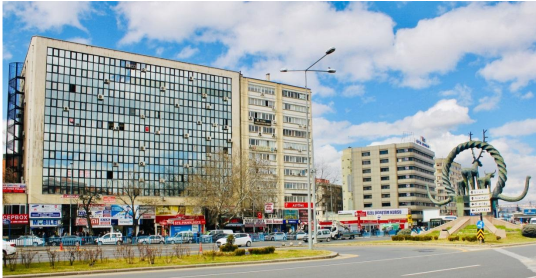
F. 229. Balıkçioğlu İş Merkezi, Genel Görünüm, 2020
