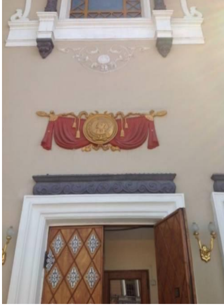
Resim 81 - Ulan Ude Hükümet Binası.
