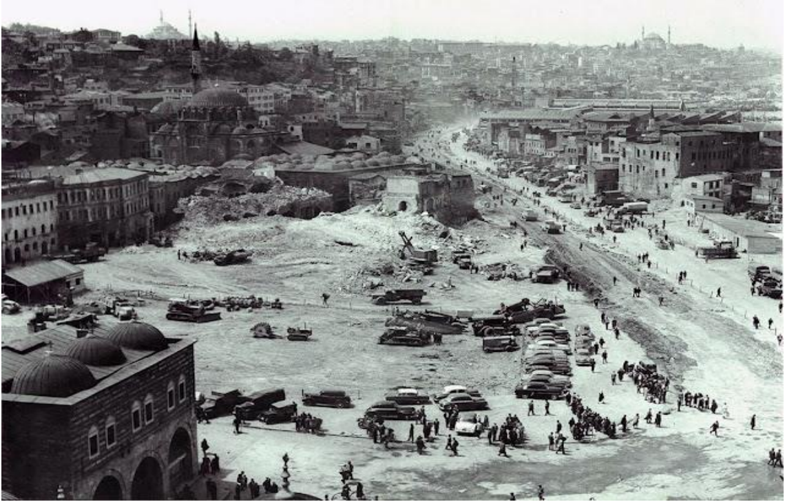
Eminönü yıkımlar zamanında-1957 (Foto:10; 7.12.2024)
