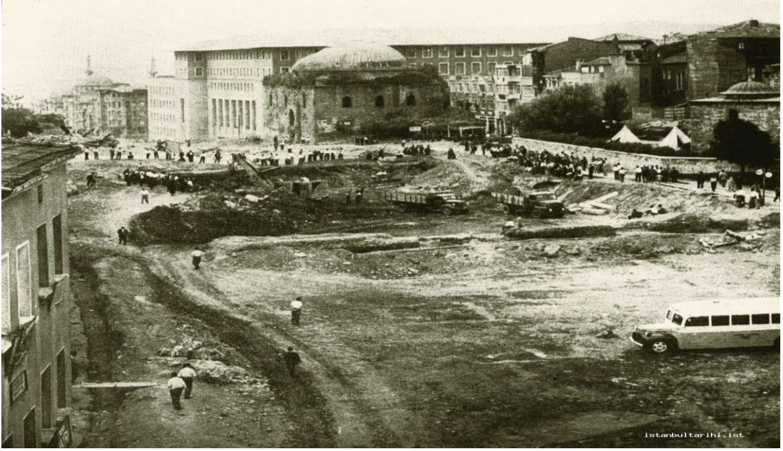
Beyazıt-Aksaray arasında kodun düşürölme çalışmaları 1957 (Foto:9 ;7.12.2024).
