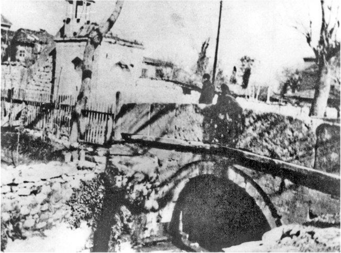
Bayram Paşa Köprüsü (Foto:32, 18.12.2024)
