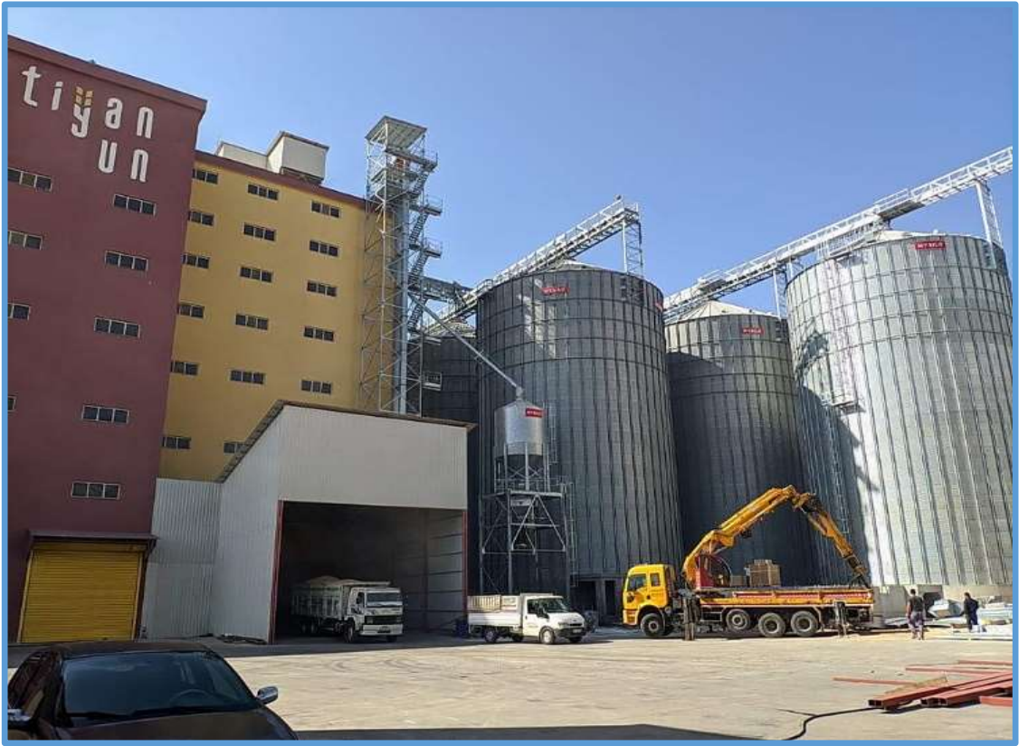
Şekil 4.6 Mardin ili Kızıltepe ilçesinde bulunan modern bir un fabrikası
