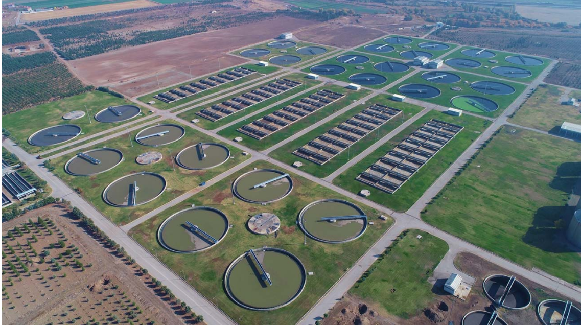
Şekil 6. Ankara Merkezi Atık Su Arıtma Tesisi (ASKİ, 2021)
