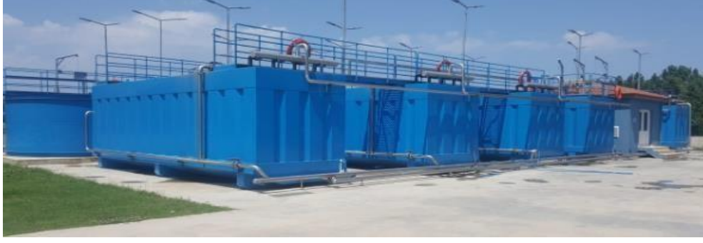
Şekil 3.24 Paket Atıksu Arıtma Sistemi
