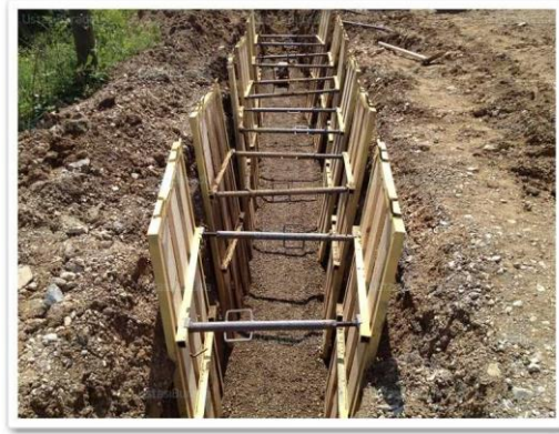
Şekil 3.29 Aralıklı Ahşap İksa Kurulu Hendek Kazısı
