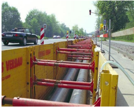
Şekil 3.30 Çelik İksa Kurulu Kanalizasyon Kazısı (Kriings Verbau)
