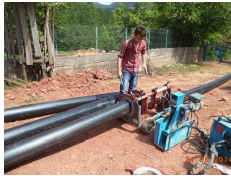
Şekil 3.21 Alın Kaynağı Uygulaması
