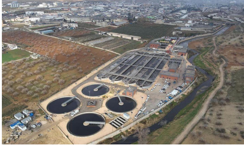
Şekil 3.23 Nizip (Gaziantep) Atıksu Arıtma Tesisi
