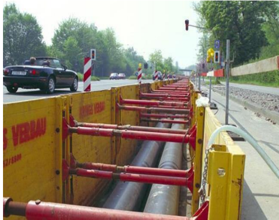
Şekil 3.13 Çelik İksalar (Krings Verbau)
