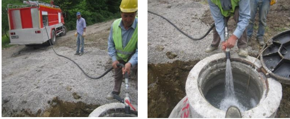
Şekil 3.15 Sızdırmazlık Testi Uygulaması
