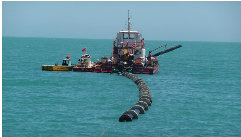
Şekil 3.27 Deniz Deşarjı İnşaatı Deniz Hattı
