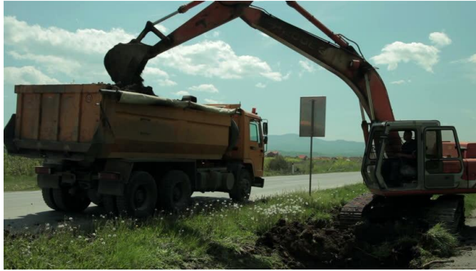
Şekil 3.28 Hendek Kazısı Sırasında Ekskavatör ve Kamyon Çalışması
