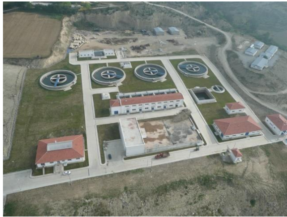
Şekil 3.25 Bolu İçmesuyu Arıtma Tesisi
