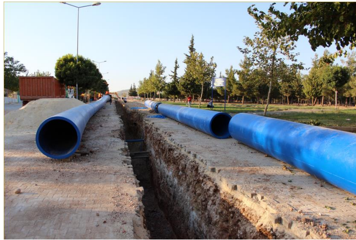
Şekil 3.17 Kilis İçmesuyu İnşaatı
