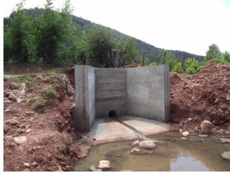
Şekil 3.11 Deşarj Yapısı Uygulaması
