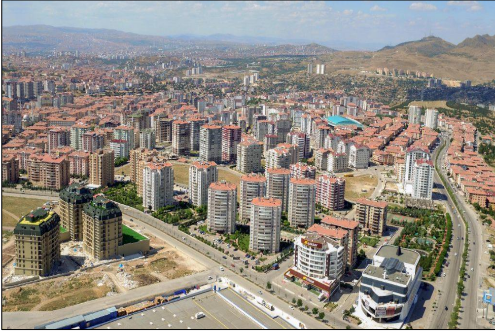
Şekil 5.8 Durali Alıç Mahallesi kentsel dönüşüm sonrası (Anonim 2024ş)
