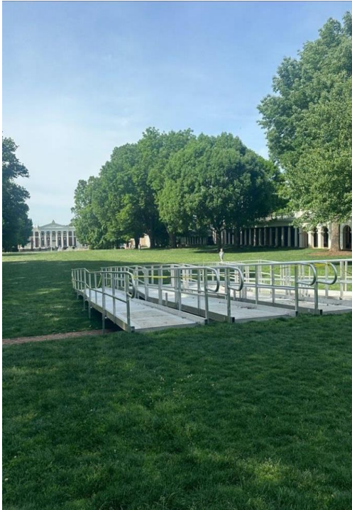
Foto 12: Aık yeřil alanda eriřilebilir dolařımı destekleyen rampa sistemi.
