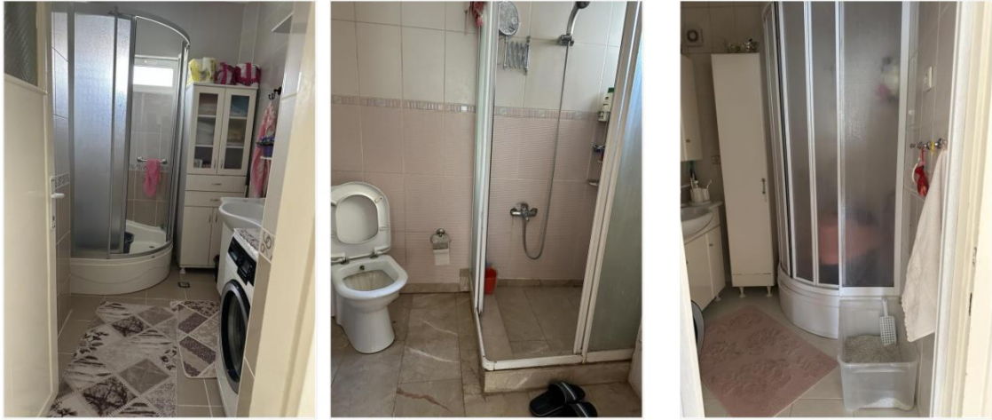
Foto 7: Yüksek duş teknesi, dar kullanım alanı ve tutunma elemanlarının yokluğu
