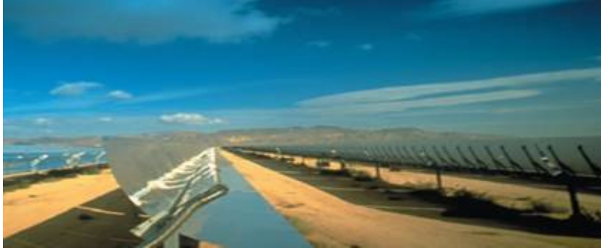
Resim 14: Güneş Termik Santrali Kollektör Alanı
