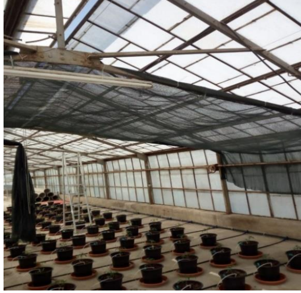
Şekil 3.36 Sera içerisine net örtü çekilmesi
